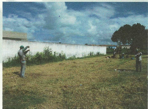
FOTO 22 OBTENÇÃO DE COTAS, ATRAVÉS DE MANGUEIRA DE NÍVEL.
