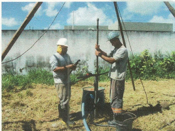
FOTO 15 EXECUÇÃO DE SONDAEM À PERCUSSÃO (SPT).
