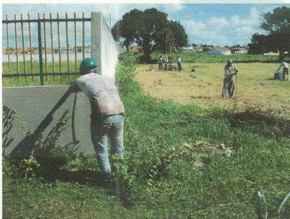
FOTO 21 OBTENÇÃO DE COTAS, ATRAVÉS DE MANGUEIRA DE NÍVEL.
