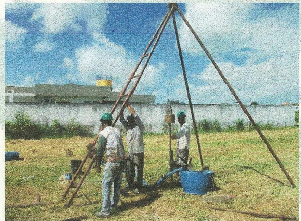
FOTO 16 EXECUÇÃO DE SONDAEM À PERCUSSÃO (SPT).
