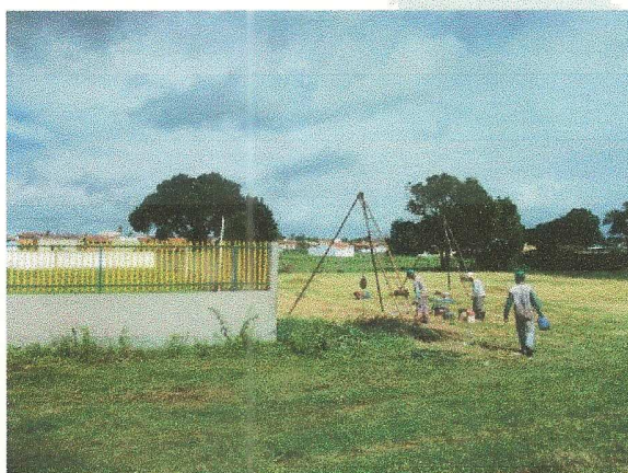
Foto 03 MOBILIZAÇÃO DE EQUIPAMENTO – INSTALAÇÃO DO TRIPÉ.
