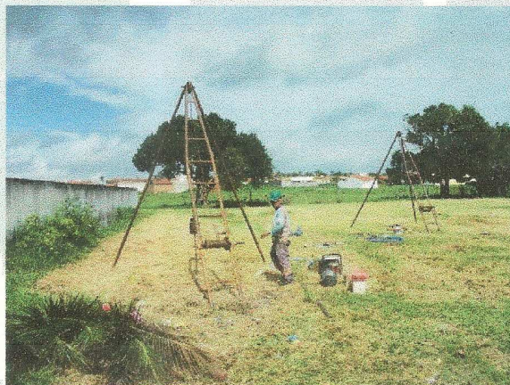
Foto 02 MOBILIZAÇÃO DE EQUIPAMENTO – INSTALAÇÃO DO TRIPÉ.
