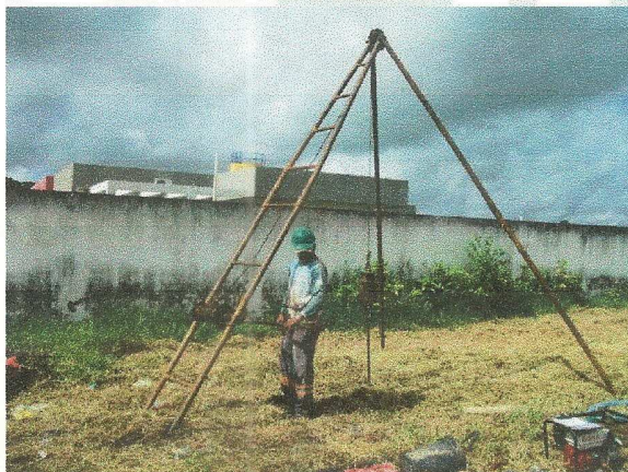
Foto 01 MOBILIZAÇÃO DE EQUIPAMENTO – INSTALAÇÃO DO TRIPÉ.
