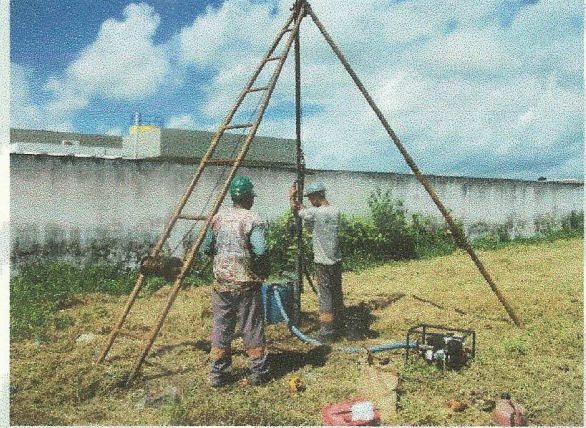
FOTO 12 EXECUÇÃO DE SONDAEM À PERCUSSÃO (SPT).
