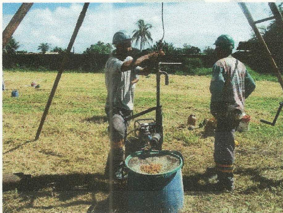
FOTO 13 EXECUÇÃO DE SONDAEM À PERCUSSÃO (SPT).
