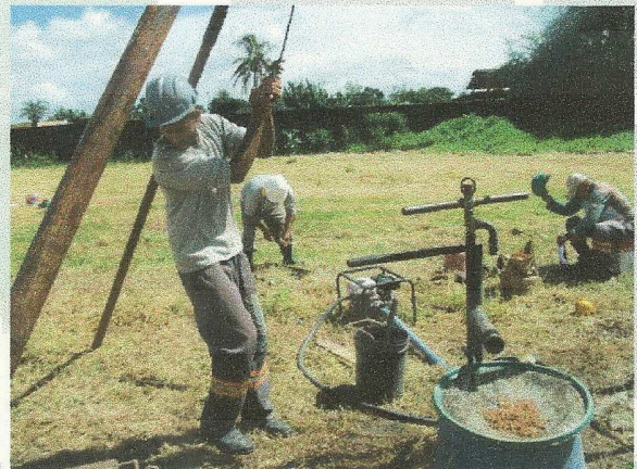
FOTO 14 EXECUÇÃO DE SONDAEM À PERCUSSÃO (SPT).
