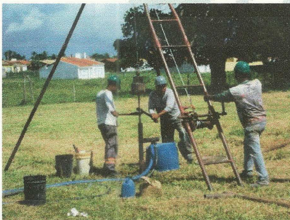
FOTO 19 EXECUÇÃO DE SONDAAGEM À PERCUSSÃO (SPT).
