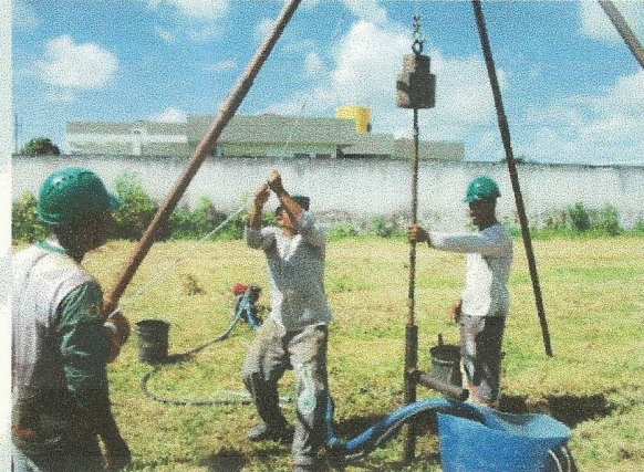
FOTO 18 EXECUÇÃO DE SONDAAGEM À PERCUSSÃO (SPT).
