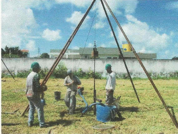
FOTO 17 EXECUÇÃO DE SONDAAGEM À PERCUSSÃO (SPT).
