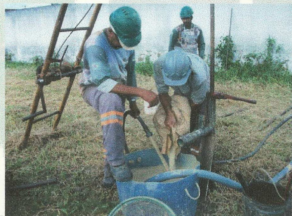
FOTO 20 EXECUÇÃO DE SONDAAGEM À PERCUSSÃO (SPT).
