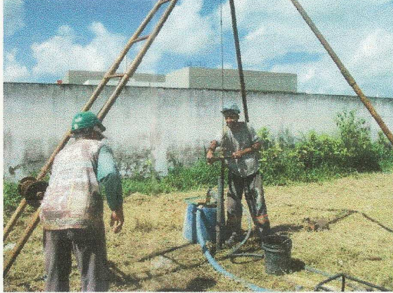
FOTO 11 EXECUÇÃO DE SONDAEM À PERCUSSÃO (SPT).
