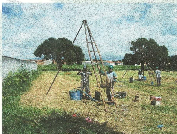
Foto 04 EXECUÇÃO DE SONDAGEM À PERCUSSÃO (SPT).
