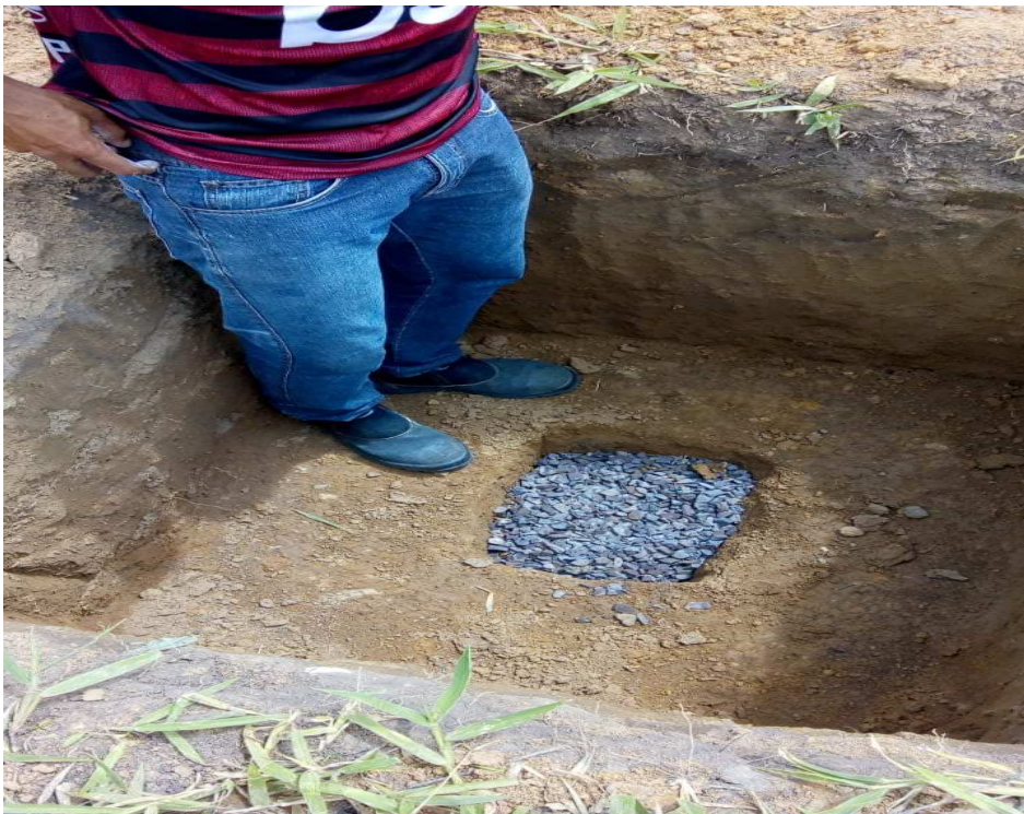
FOTO 02 -PREENCHIMENTO COM BRITA
