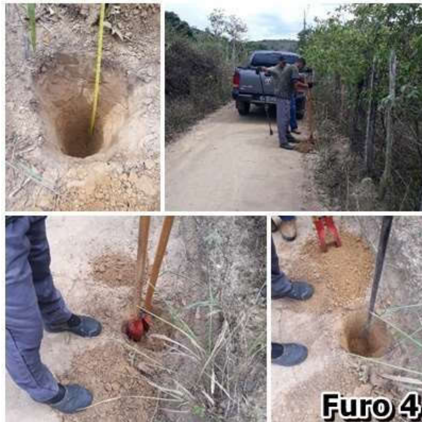
Figura 8 - Registro fotográfico do Furo 4.
