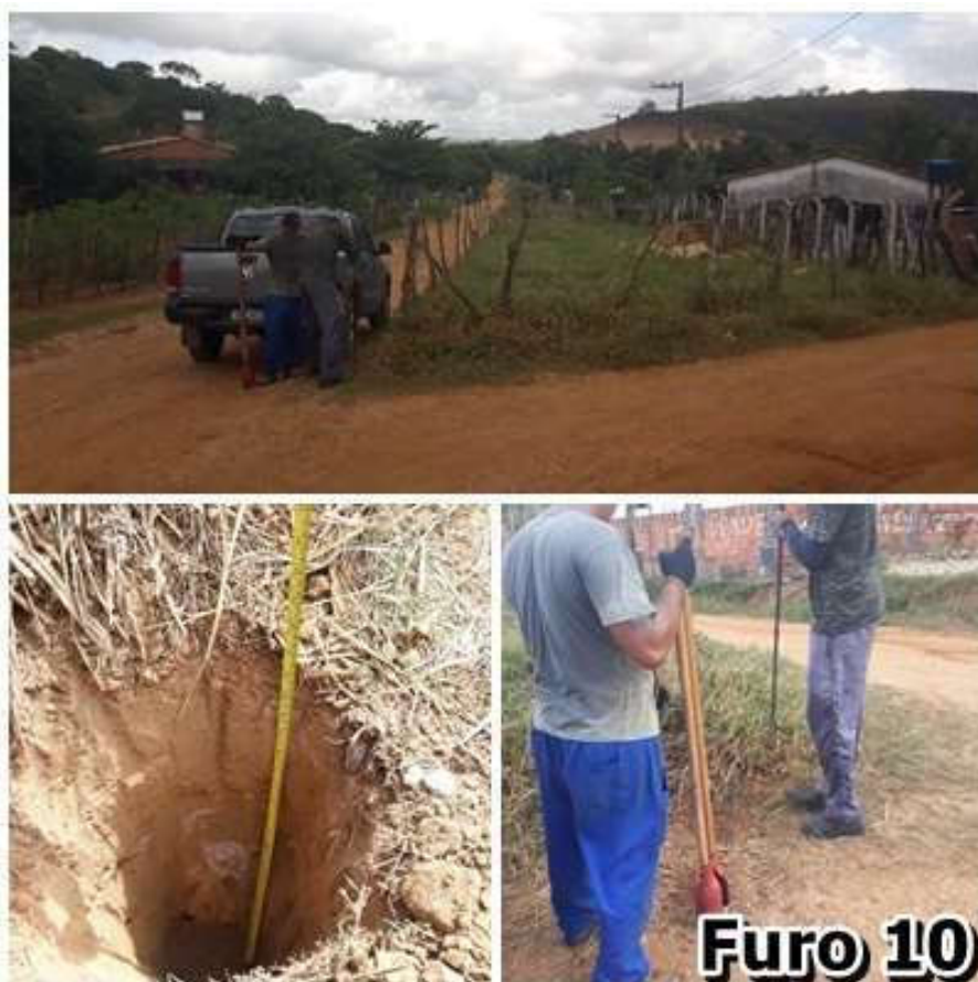
Figura 14 - Registro fotográfico do Furo 10.
