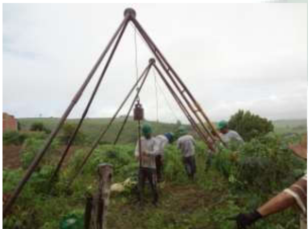
FOTO 07 EXECUÇÃO DE SONDAGEM À PERCUSSÃO (SPT).
