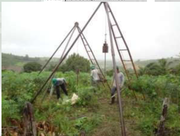
Foto 04 EXECUÇÃO DE SONDAGEM À PERCUSSÃO (SPT).
