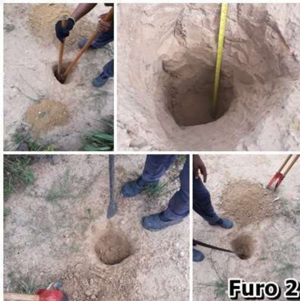
Figura 6 - Registro fotográfico do Furo 2.
