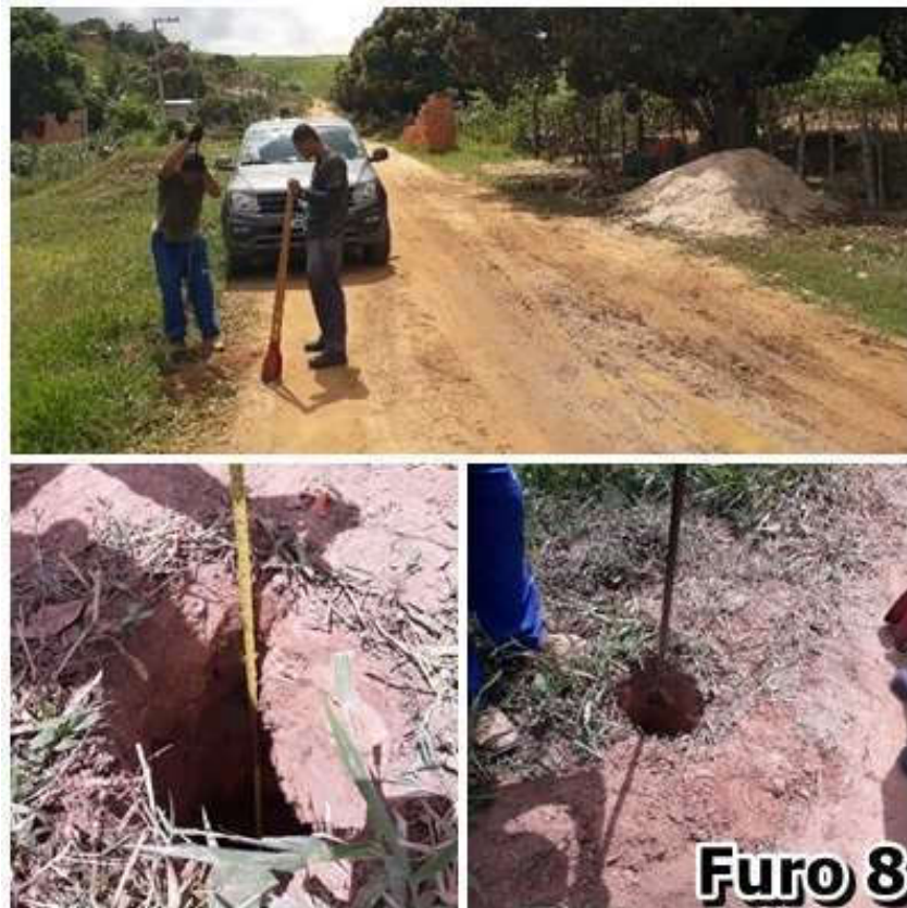
Figura 12 - Registro fotográfico do Furo 8.
