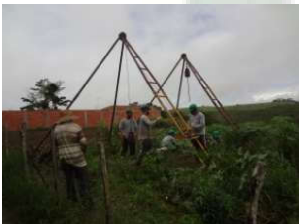
FOTO 11 EXECUÇÃO DE SONDAGEM À PERCUSSÃO (SPT).
