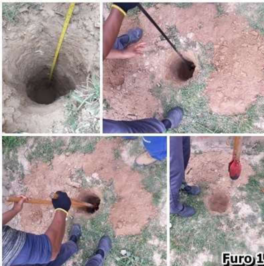
Figura 5 - Registro fotográfico do Furo 1.
