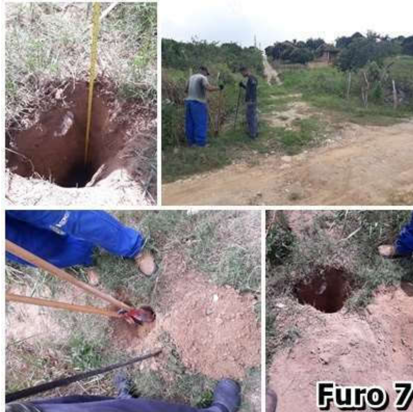
Figura 11 - Registro fotográfico do Furo 7.
