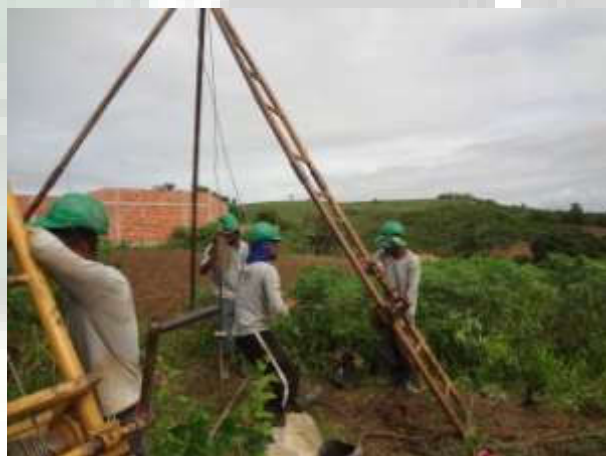
FOTO 16 EXECUÇÃO DE SONDAGEM À PERCUSSÃO (SPT).
