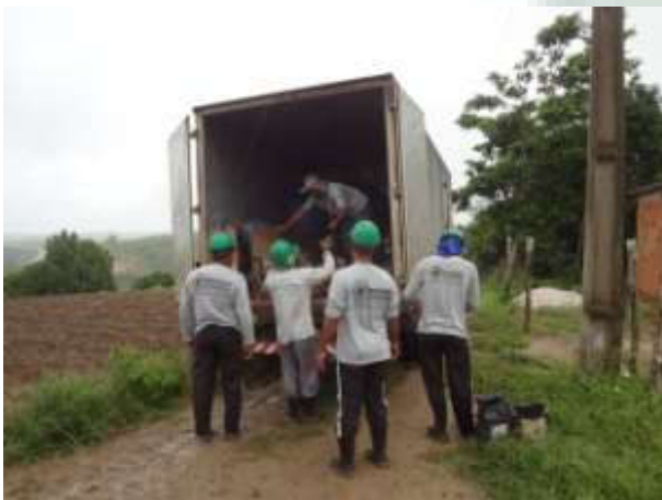
Foto 01 MOBILIZAÇÃO DOS EQUIPAMENTOS.
