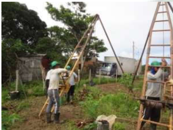
FOTO 13 EXECUÇÃO DE SONDAGEM À PERCUSSÃO (SPT).
