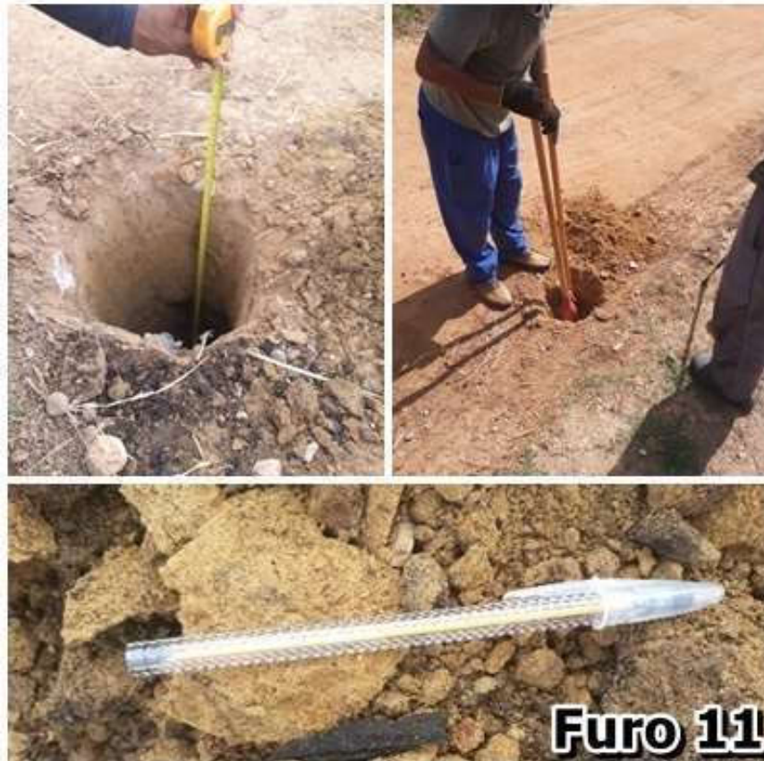
Figura 15 - Registro fotográfico do Furo 11.
