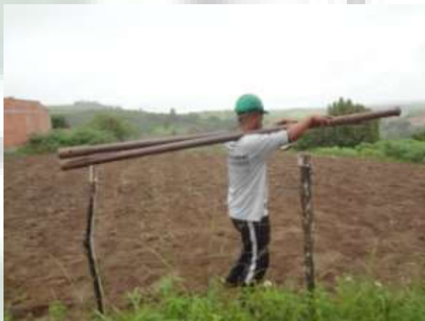
Foto 02 MOBILIZAÇÃO DOS EQUIPAMENTOS.
