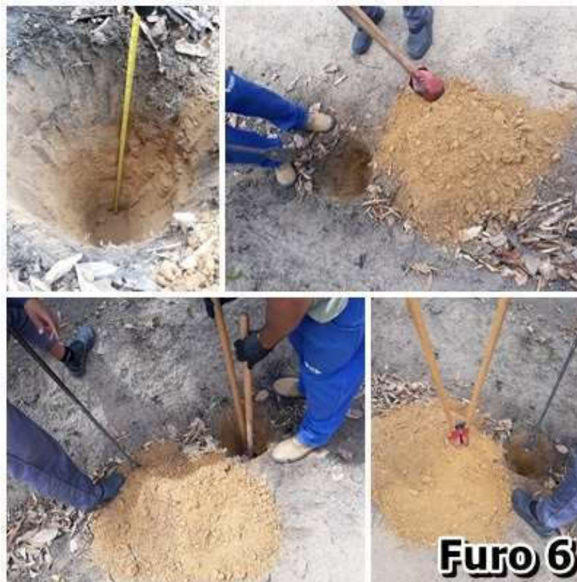
Figura 10 - Registro fotográfico do Furo 6.
