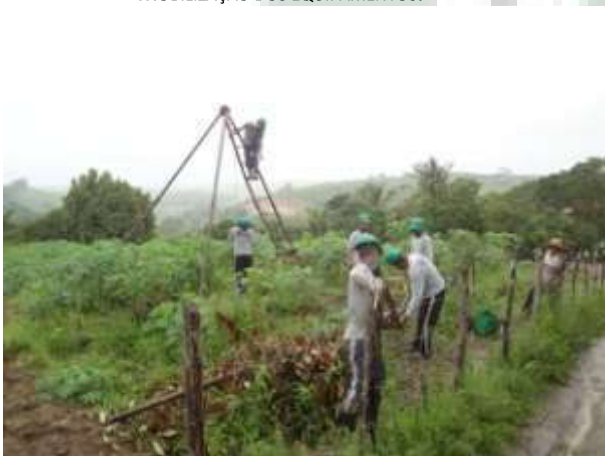
Foto 03 MOBILIZAÇÃO DOS EQUIPAMENTOS – INSTAL. TRIPÉ.
