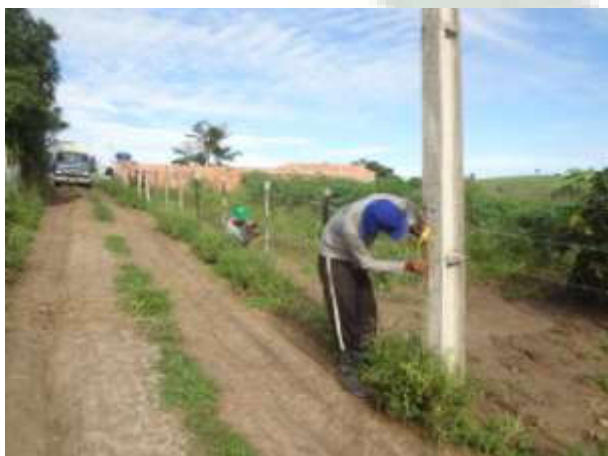
FOTO 17 OBTENÇÃO DE COTAS, ATRAVÉS DE MANGUEIRA DE NÍVEL.
