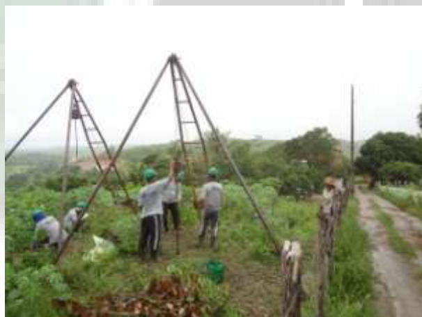
FOTO 10 EXECUÇÃO DE SONDAGEM À PERCUSSÃO (SPT).
