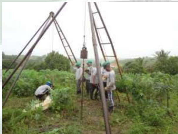
FOTO 08 EXECUÇÃO DE SONDAGEM À PERCUSSÃO (SPT).
