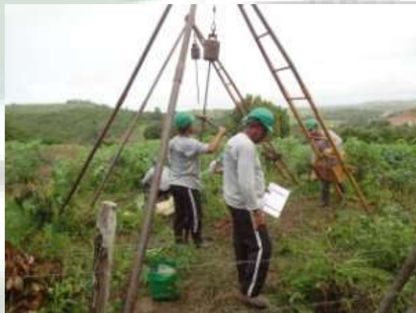
FOTO 14 EXECUÇÃO DE SONDAGEM À PERCUSSÃO (SPT).
