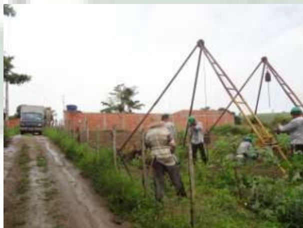
FOTO 12 EXECUÇÃO DE SONDAGEM À PERCUSSÃO (SPT).
