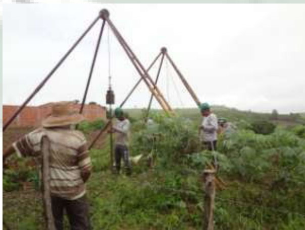
Foto 06 EXECUÇÃO DE SONDAGEM À PERCUSSÃO (SPT).
