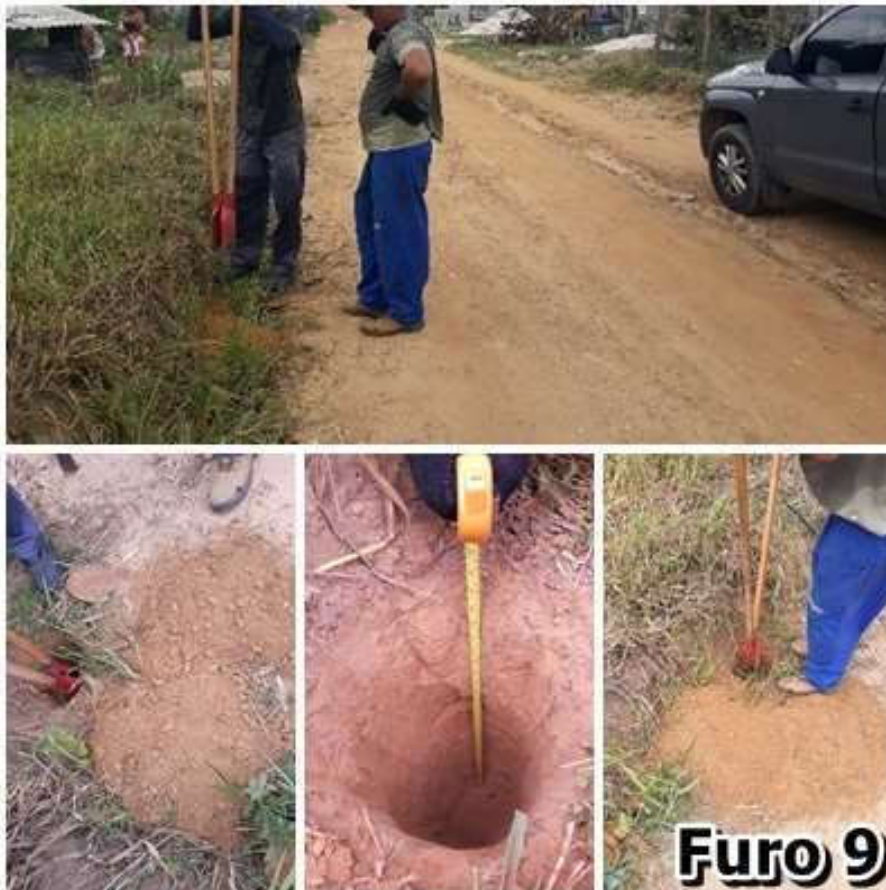
Figura 13 - Registro fotográfico do Furo 9.
