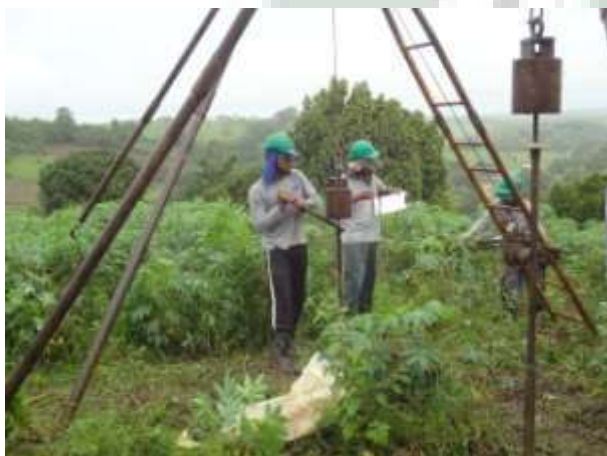
FOTO 09 EXECUÇÃO DE SONDAGEM À PERCUSSÃO (SPT).
