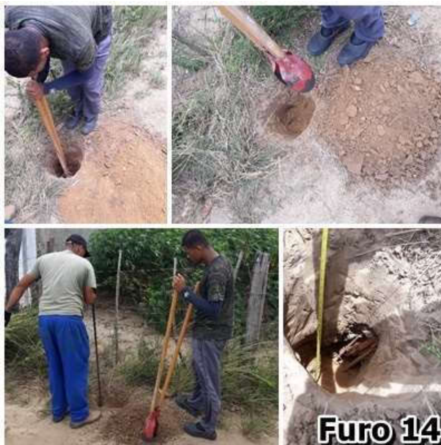
Figura 18 - Registro fotográfico do Furo 14.
