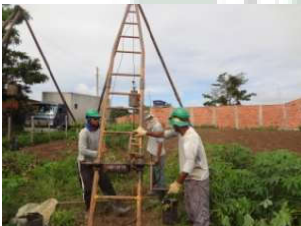
FOTO 15 EXECUÇÃO DE SONDAGEM À PERCUSSÃO (SPT).
