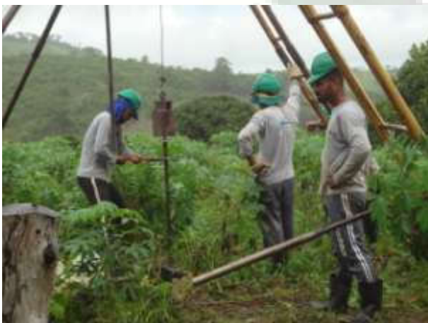
Foto 05 EXECUÇÃO DE SONDAGEM À PERCUSSÃO (SPT).
