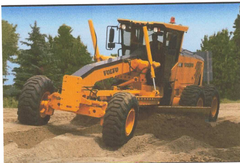
Imagem 01: Motoniveladora regularizando o terreno
