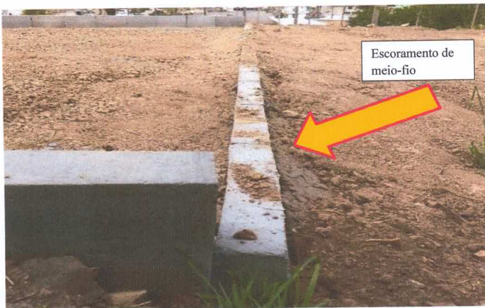
Imagem 05: Representação da Execução do Escoramento Contínuo do meio-fio.
