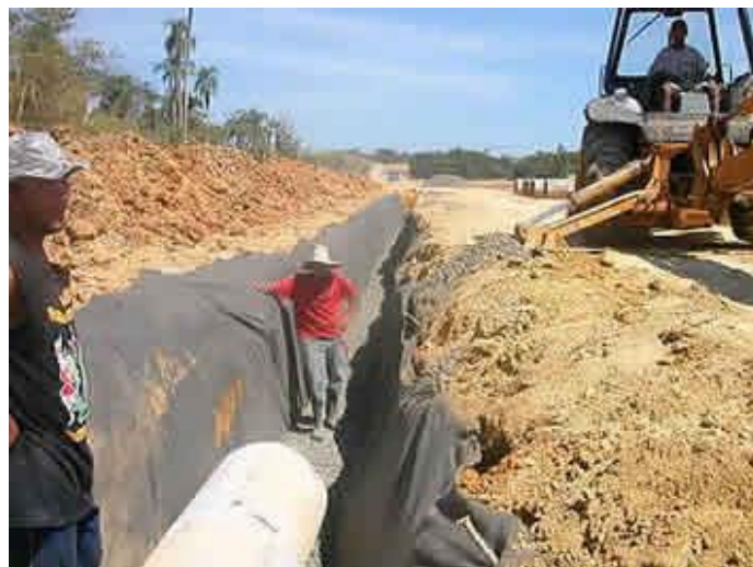
Figura 6:3: Execução da drenagem de lixiviado.
