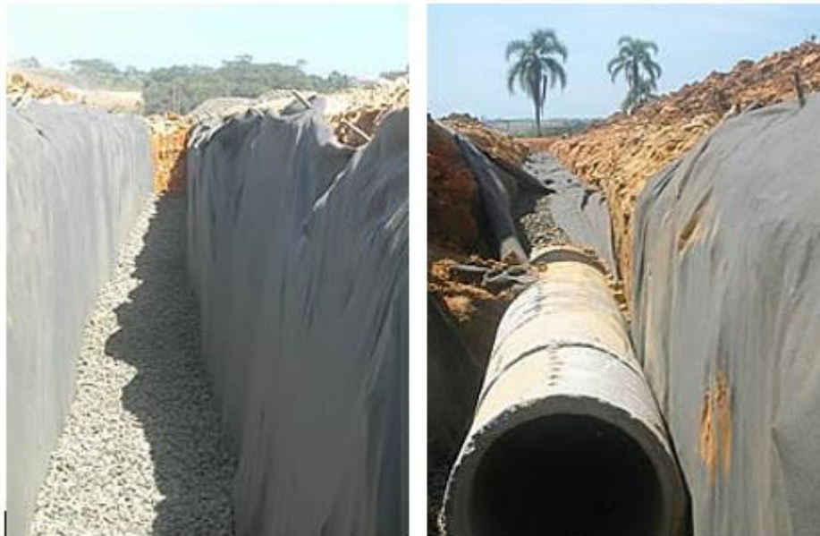
Figura 6:2: Execução da drenagem de lixiviado.
