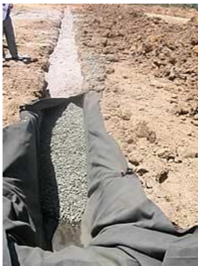
Figura 6:4: Execução da drenagem de lixiviado.
