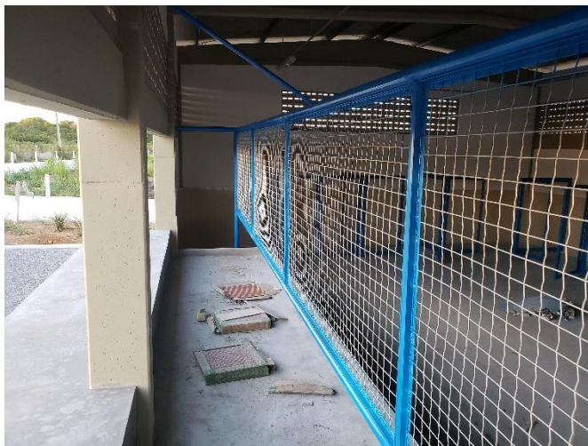
Figura 7.8: Silo de reciclagem Central de Triagem de Lagoa Nova/RN
