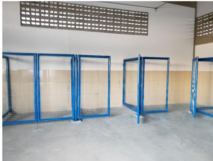
Figura 7.10: Baias para armazenamento -Central de Triagem de Lagoa Nova/RN
