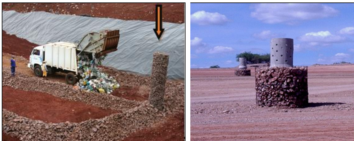
Figura 2.5 – Sistema de Drenagem de Gases
