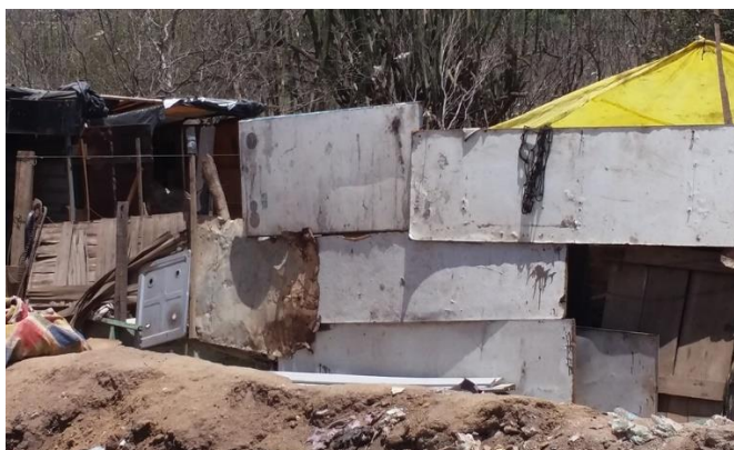
Estruturas bastante precárias utilizadas pelos catadores que atuam na área do lixão como pontos de apoio
