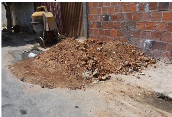
Deposição inadequada de entulho de construção civil em via pública.
