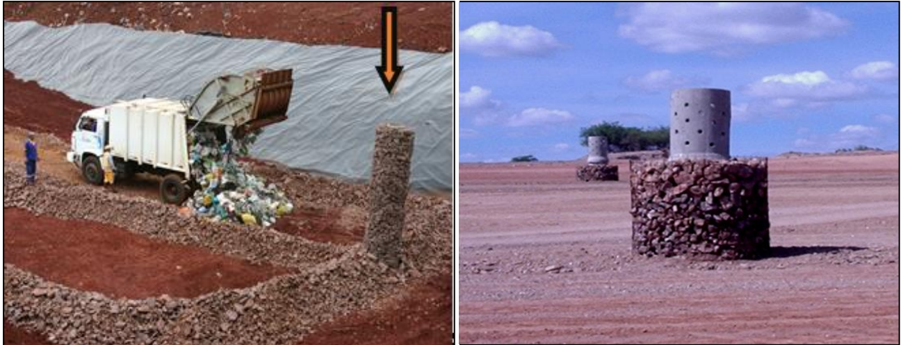
Figura 2.6 – Sistema de Drenagem de Gases
