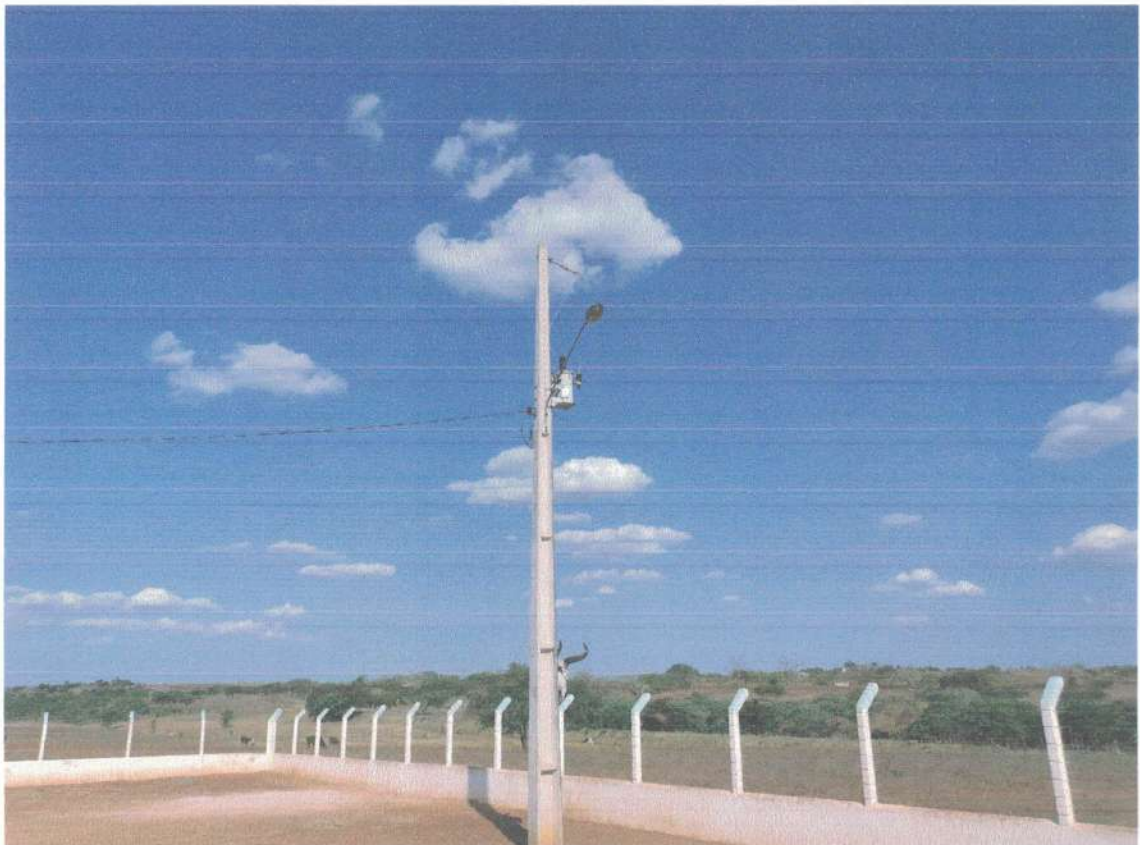
ENERGIA ELETRICA ABASTECENDO A PROPRIEDADE
