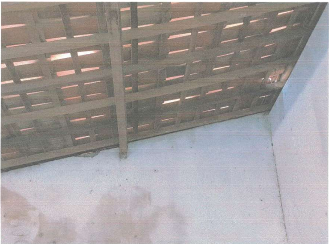
TELHA APARENTE DA ÁREA DE LASER E SEDE PRINCIPAL
