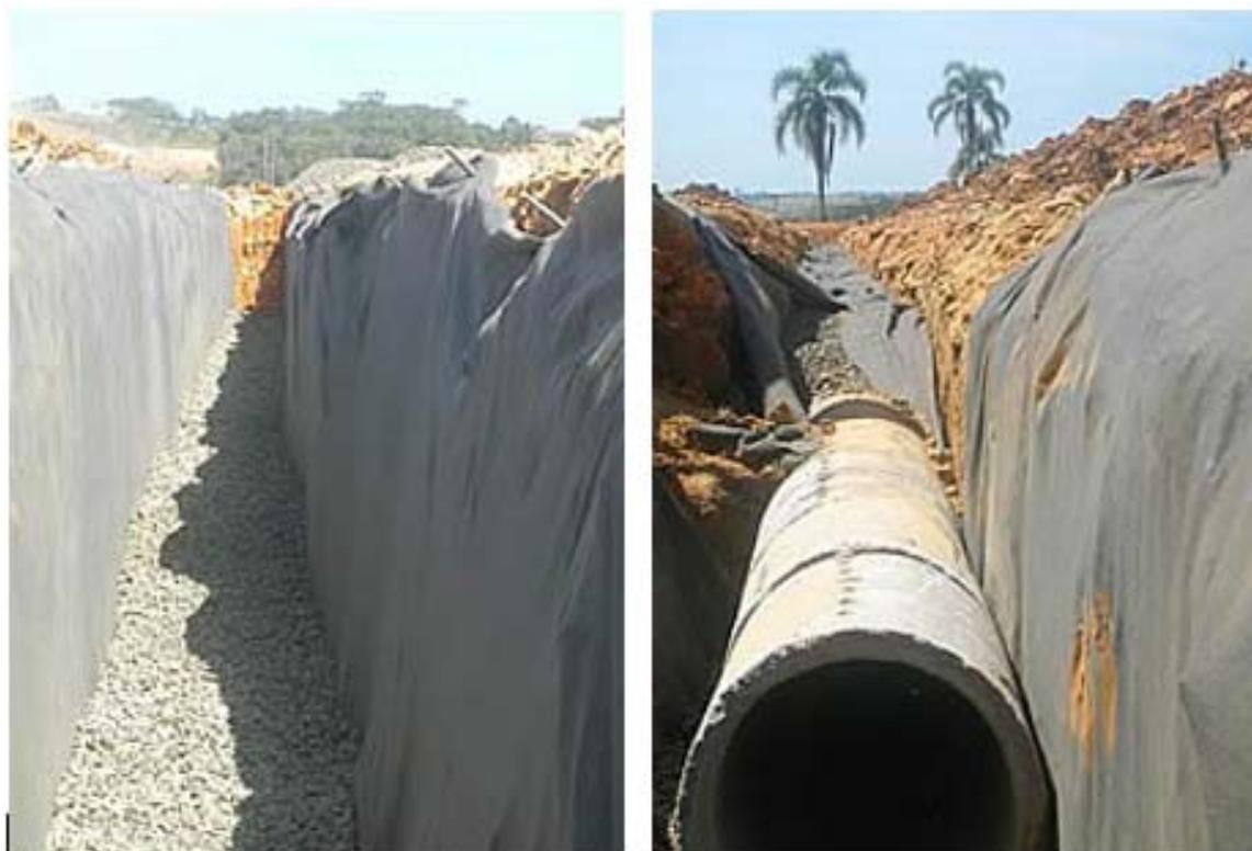
Figura 8.6: Execução da drenagem de lixiviado.
