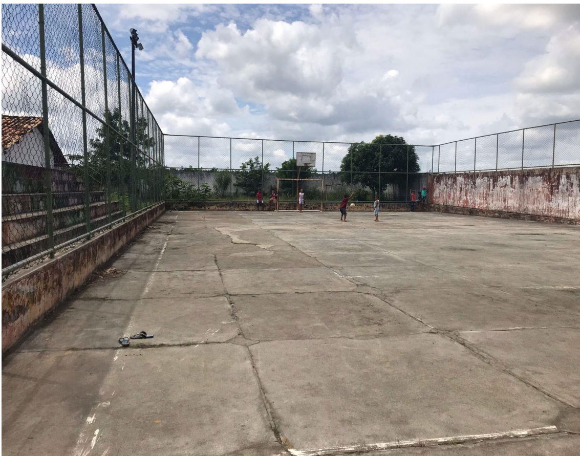
Figura 2: Área da Quadra Poliesportiva que será regularizada e colocado piso de alta resistência
