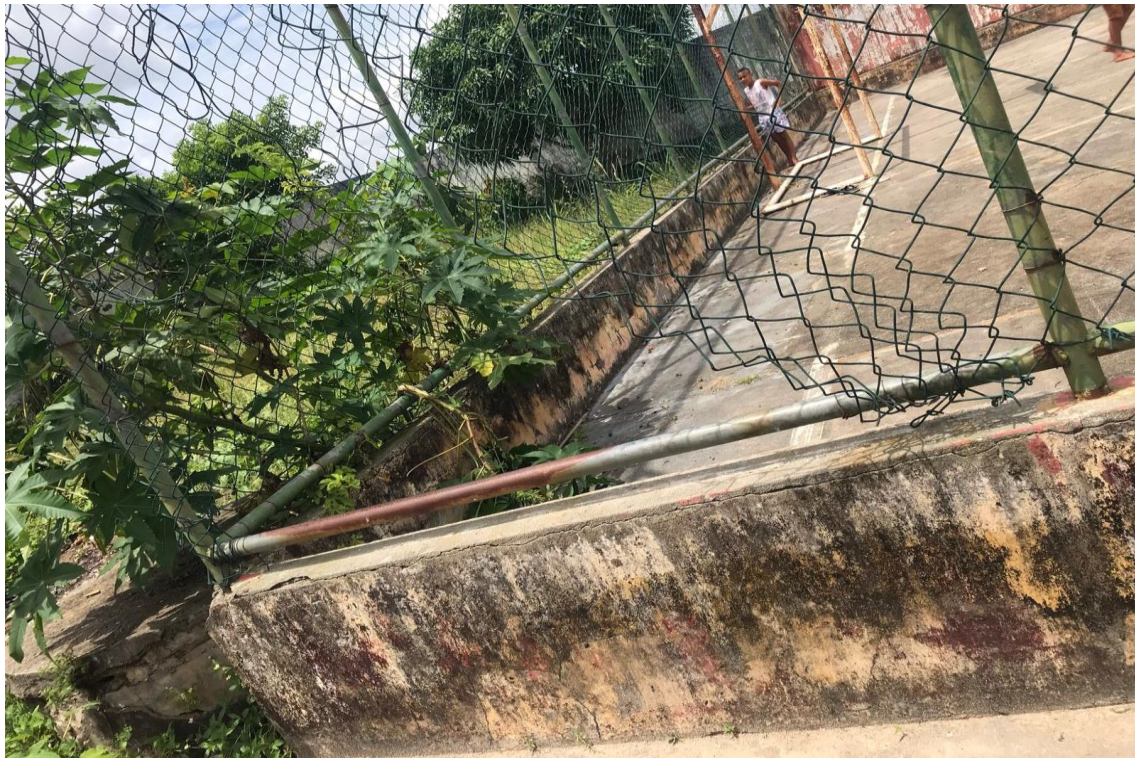
Figura 7: Remoção e Colocação de Malha de aço do alambrado
