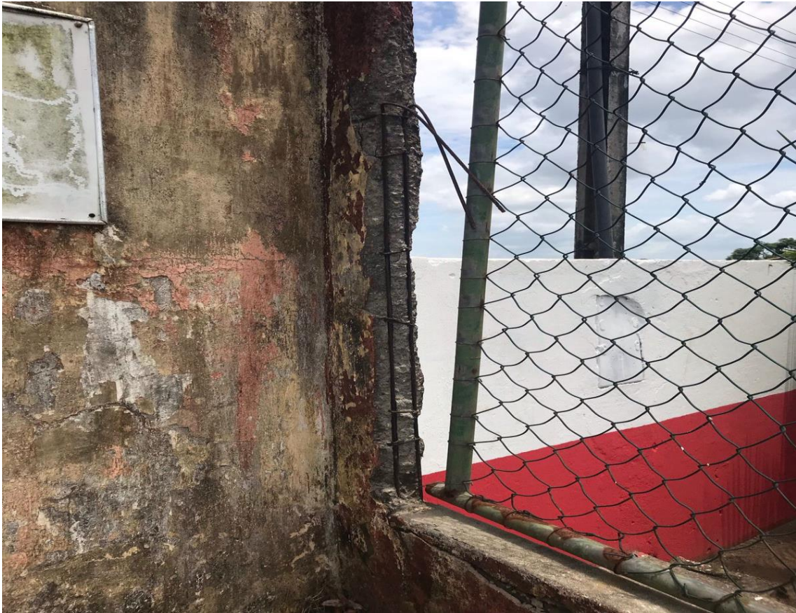
Figura 9: Recuperação Estrutural do pilar da quadra
