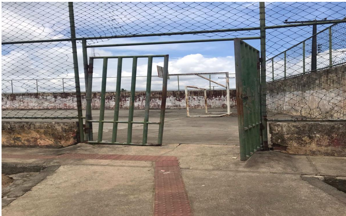
Figura 8: Revisão do portão metálico do alambrado
