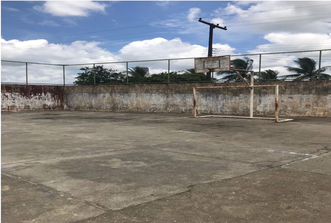
Figura 3: Trave de futsal e tabela com cesta de vôlei necessitando lixamento, tratamento e pintura
