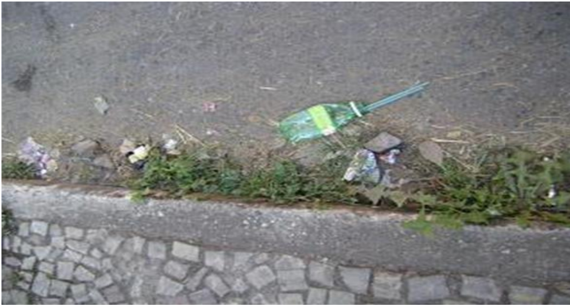
Exemplo de sarjeta necessitando de capinação e raspagem de terra
