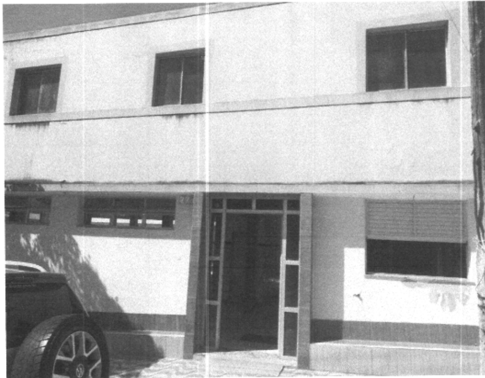
Foto 2 -- Piso no nível da rua
