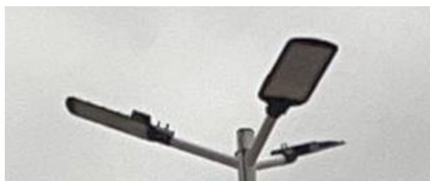
Depois da implantação das luminárias
