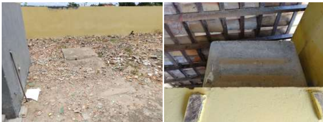
FOTO 03: ÁREA EXTERNA CAIXA DE INSPEÇÃO / CAIXA D'ÁGUA ÁREA INTERNA FONTE: JOHN ÁLEX – DATA: 26/02/2022
