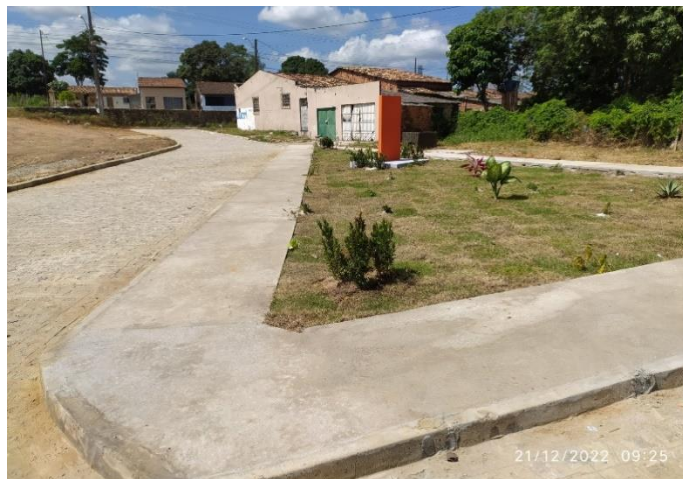
Foto 06: : Pavimentação e esgotamento no loteamento Japuí II.
