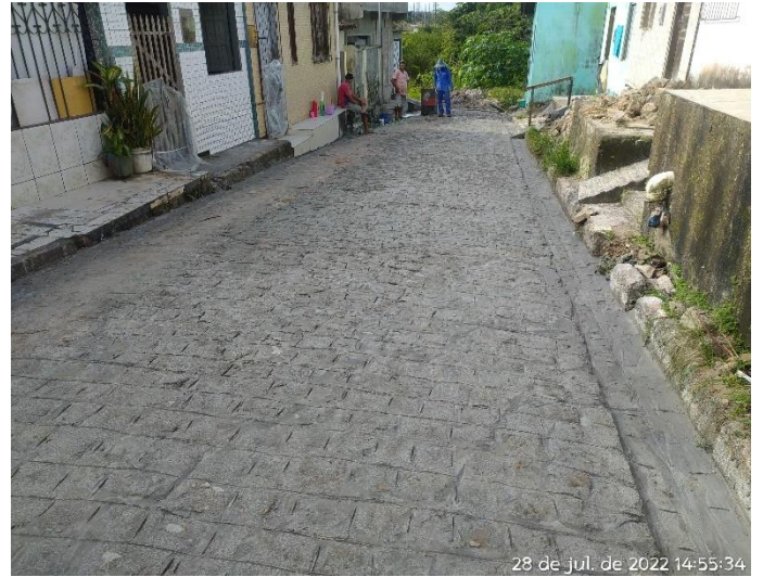
Foto 16: Recuperação de Ruas No Bairro Pedra Branca.
