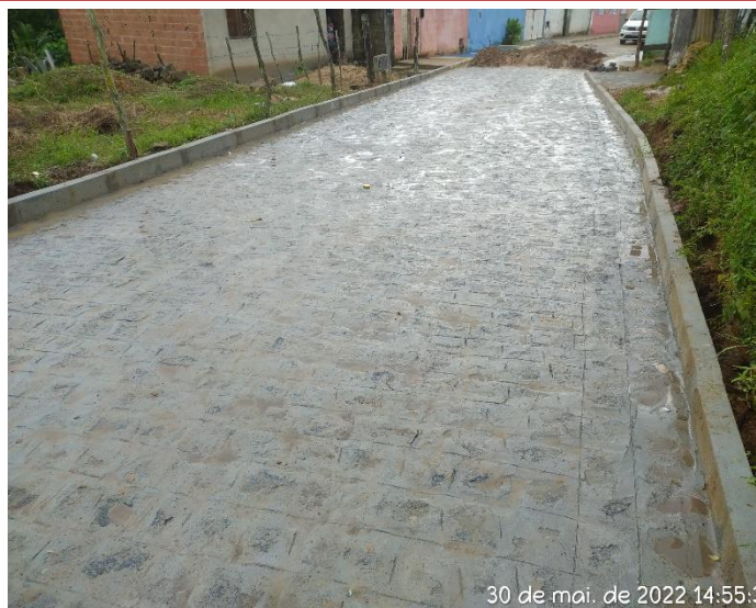
Foto 12: Pavimentação em paralelepípedo e drenagem superficial entre Salinas e Conjunto Mutirão.
