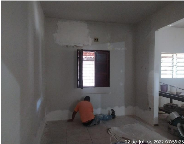
Foto 01: Reforma do CAPS – Centro de Atendimento Psicosocial.
