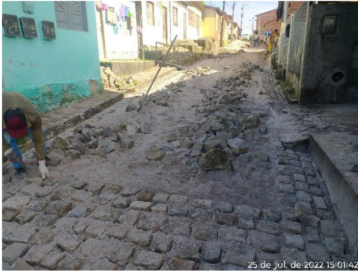
Foto 15: Recuperação de Ruas No Bairro Pedra Branca.
