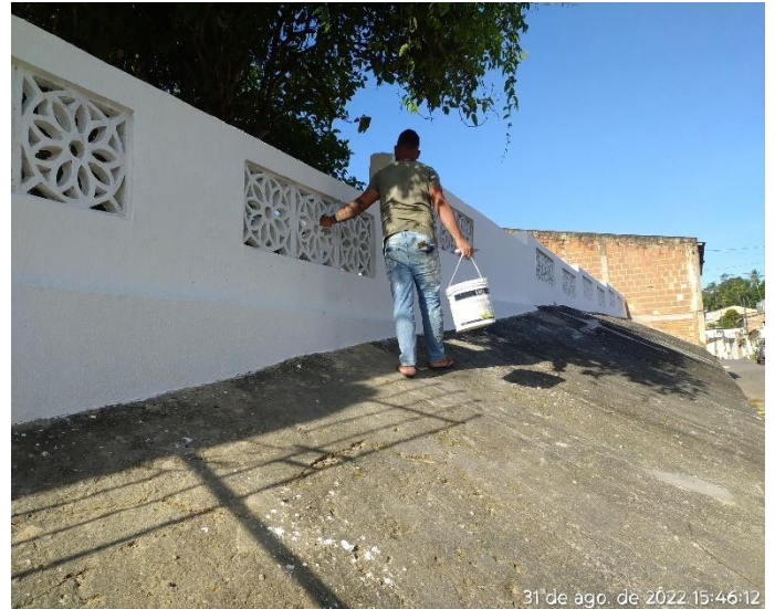
Foto 02: Reforma do CAPS – Centro de Atendimento Psicosocial.
