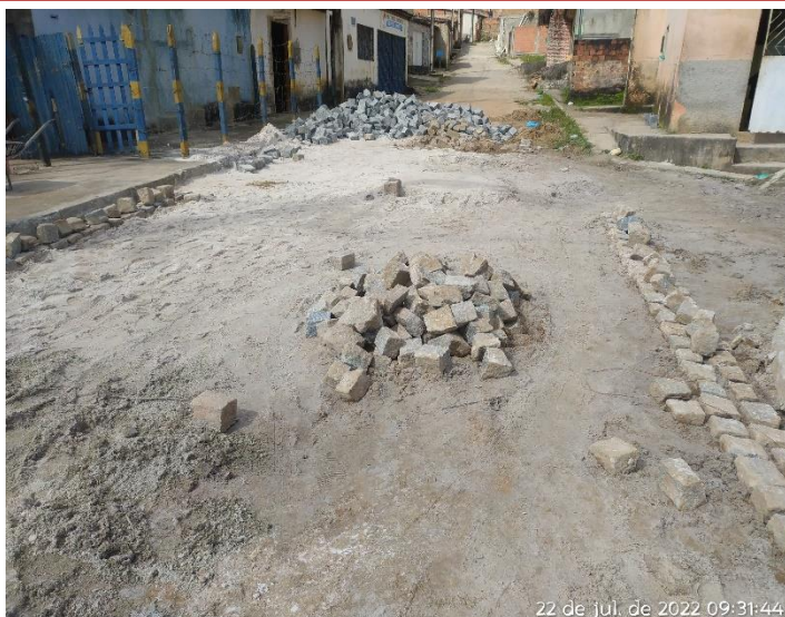
Foto 11: Pavimentação em paralelepípedo e drenagem superficial entre Salinas e Conjunto Mutirão.
