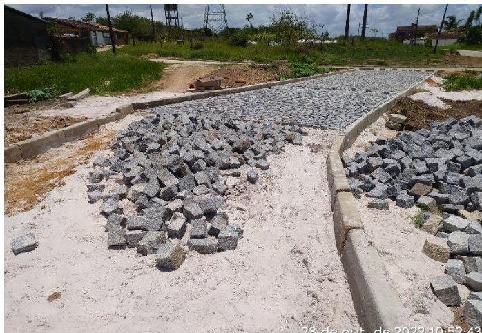
Foto 05: Pavimentação e esgotamento no loteamento Japuí II.
