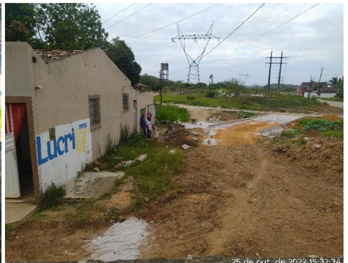
Foto 04: Pavimentação e esgotamento no loteamento Japuí II.
