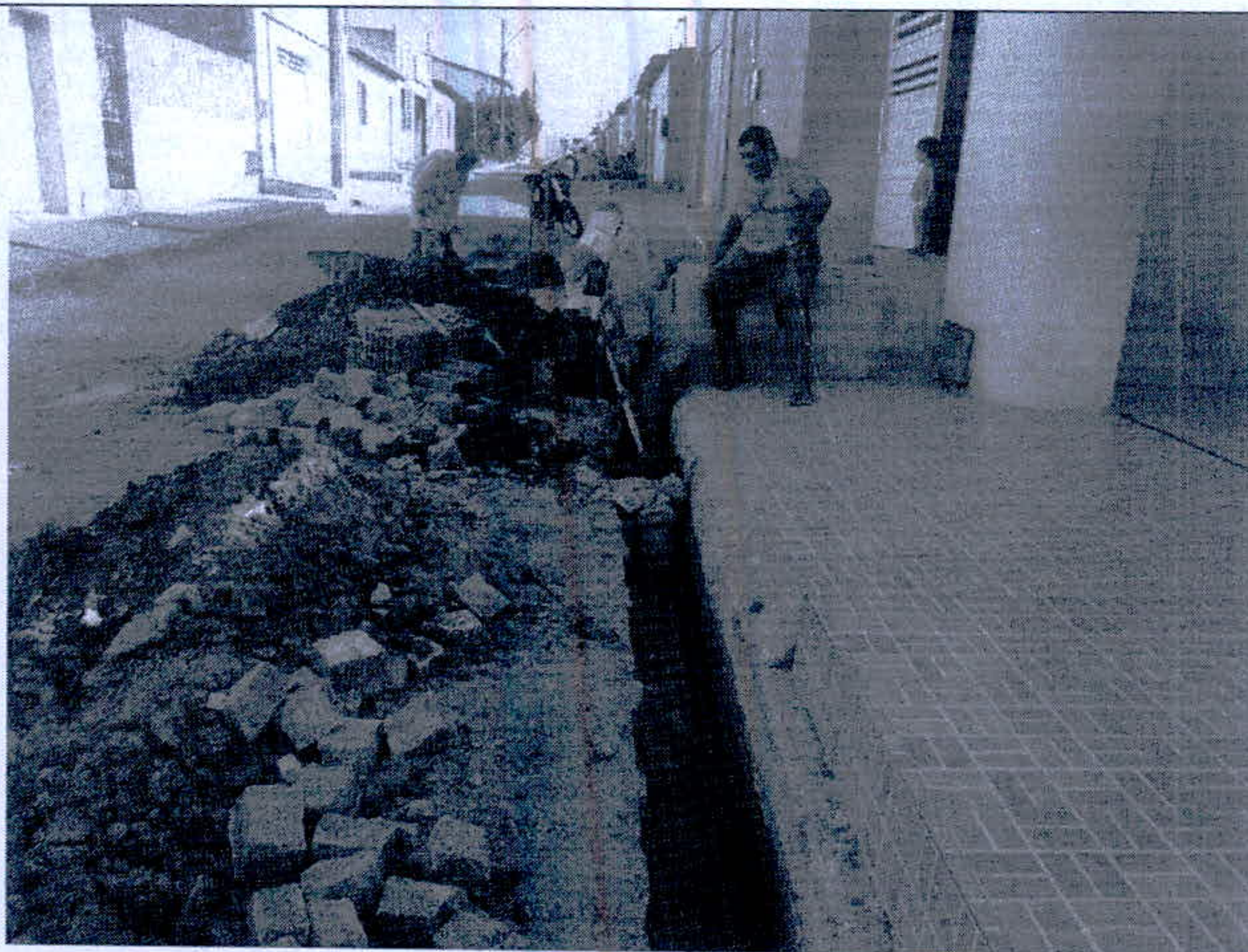
Figura 500 - Rua B do Conj. Nossa Senhora das Graças - Esgotamento sanitário
