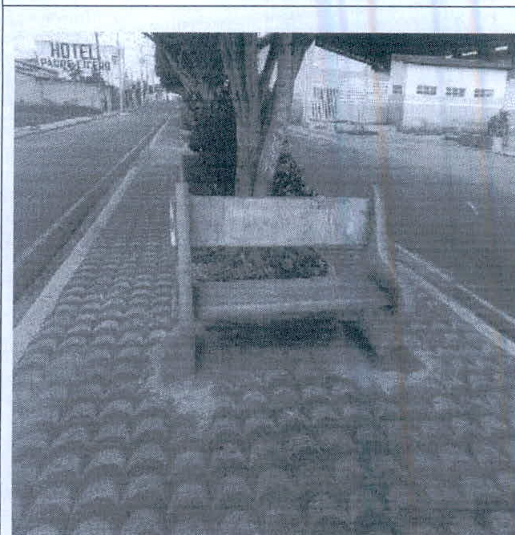
Figura 47 - Avenida Conego M Barbosa - Recuperação de Bancos de concreto
