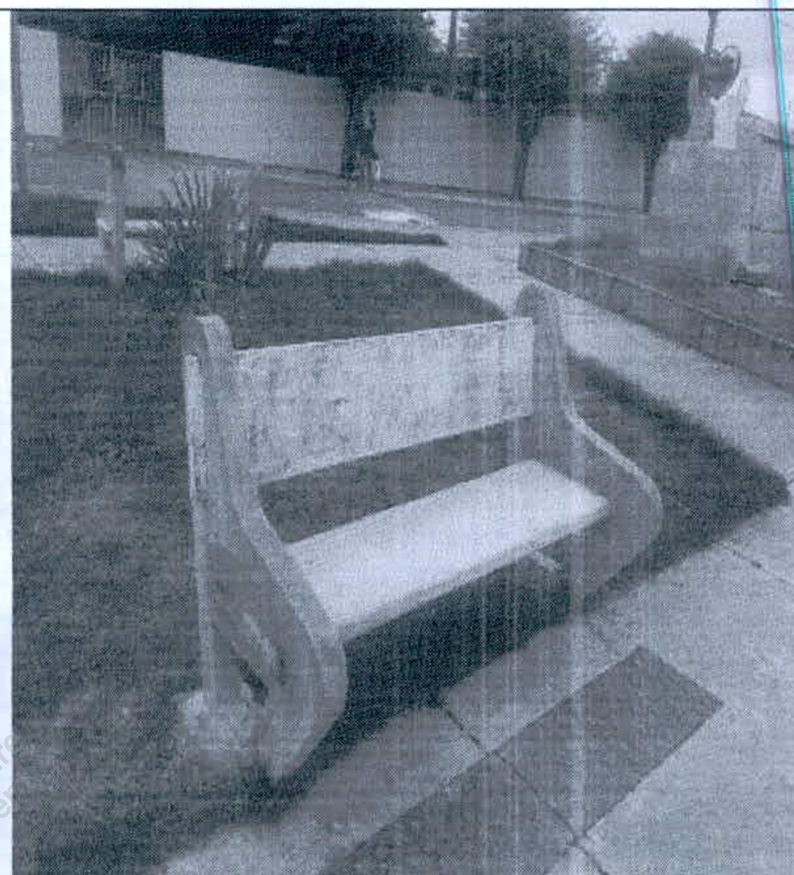
Figura 46 - Avenida Conego M Barbosa - Recuperação de Bancos de concreto
