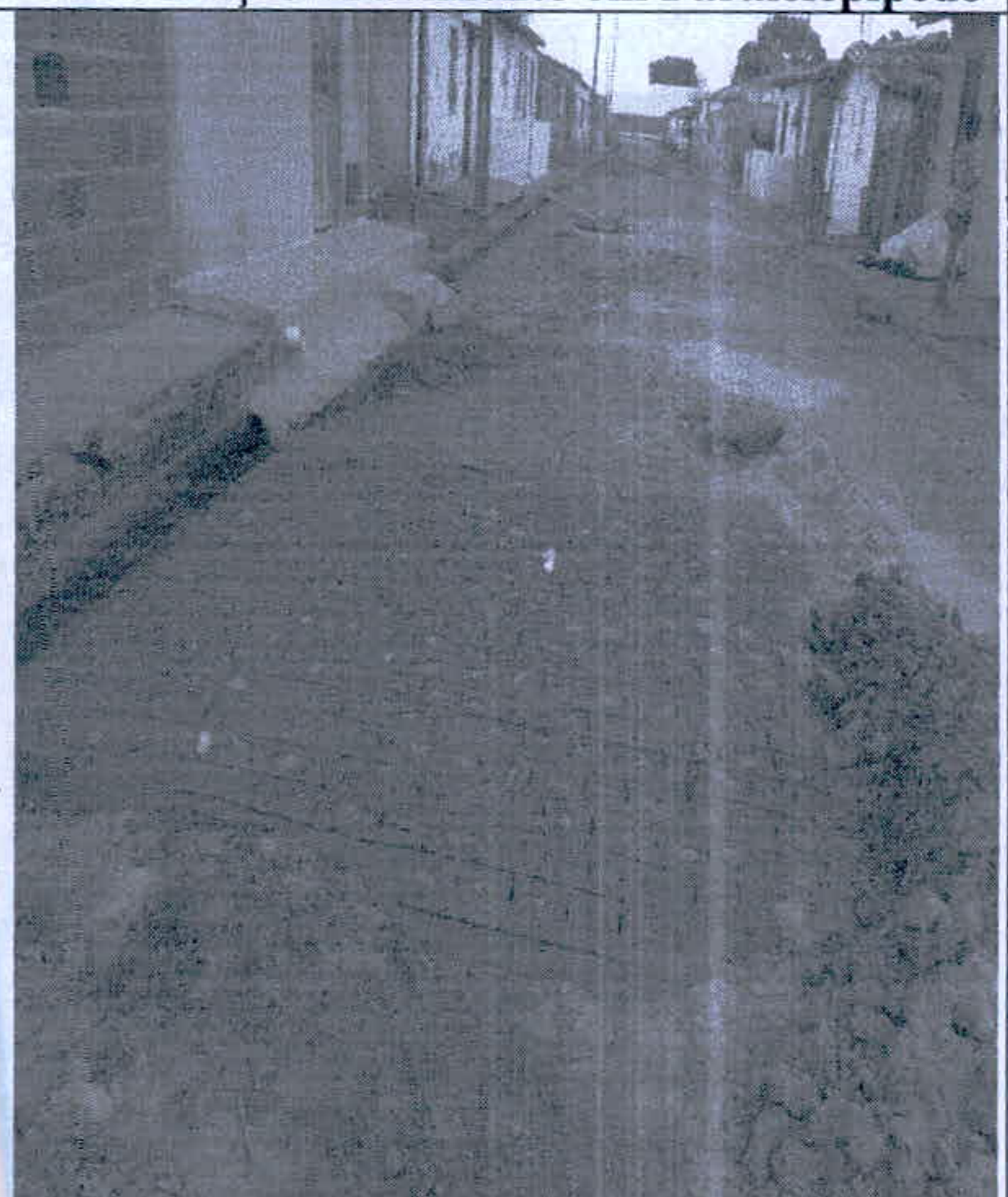
Figura 24 - Loteamento Nossa Senhora das Graças - Pavimento em Paralelepípedo
