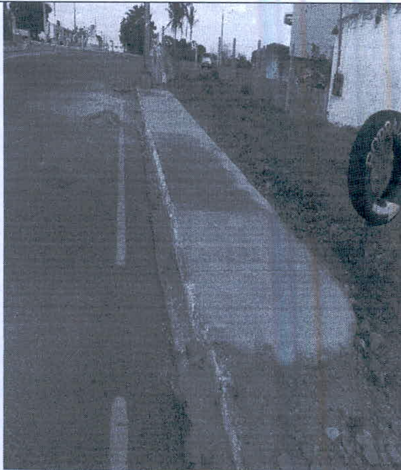
Figura 35 - Avenida Conego Miguel - Demolição de pisos de concreto / Piso de concreto desempolado
