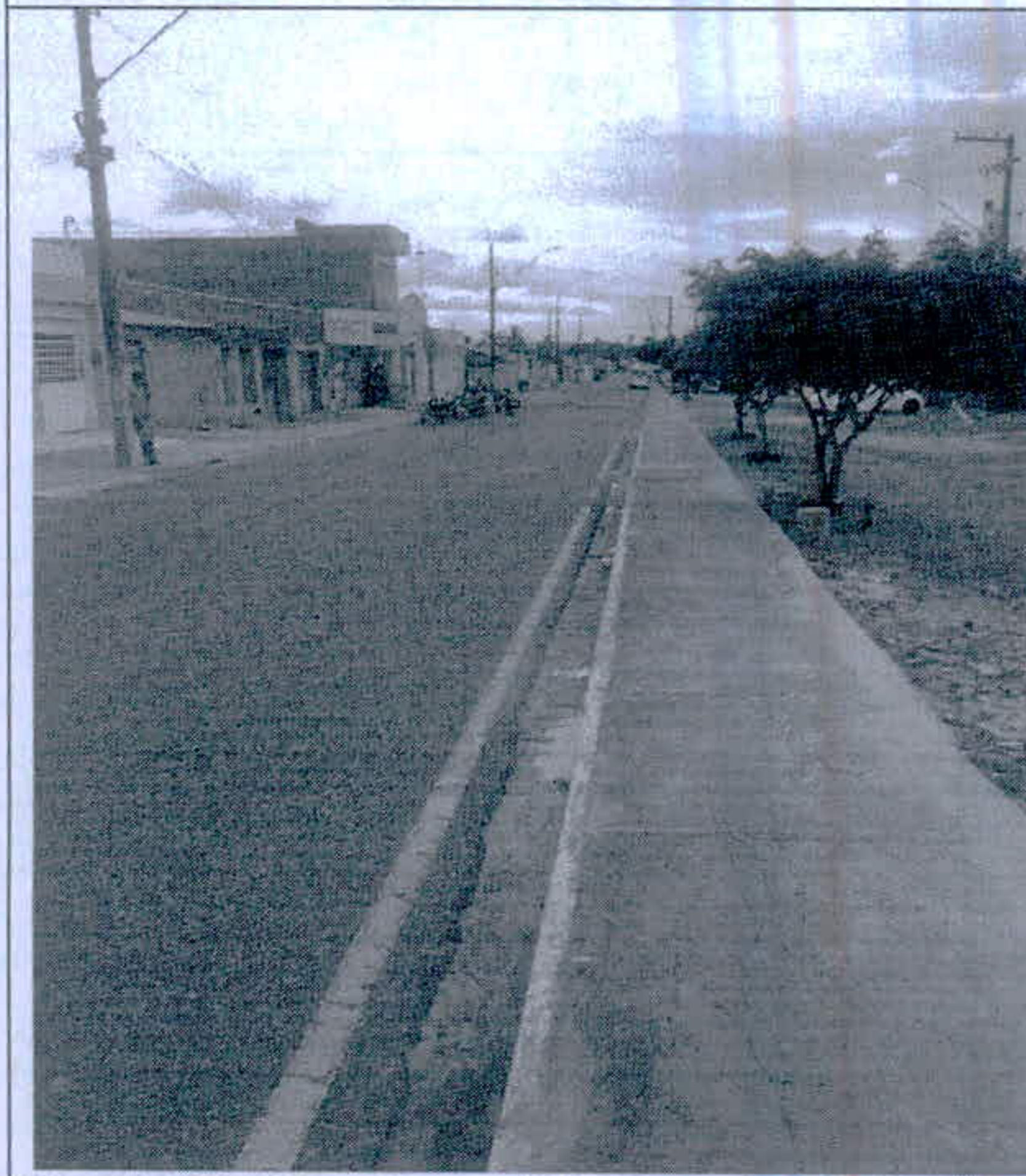
Figura 43 - Rua Petronidio Menezes de Cutia - Demolição de pisos de concreto / Piso de concreto desempolado
