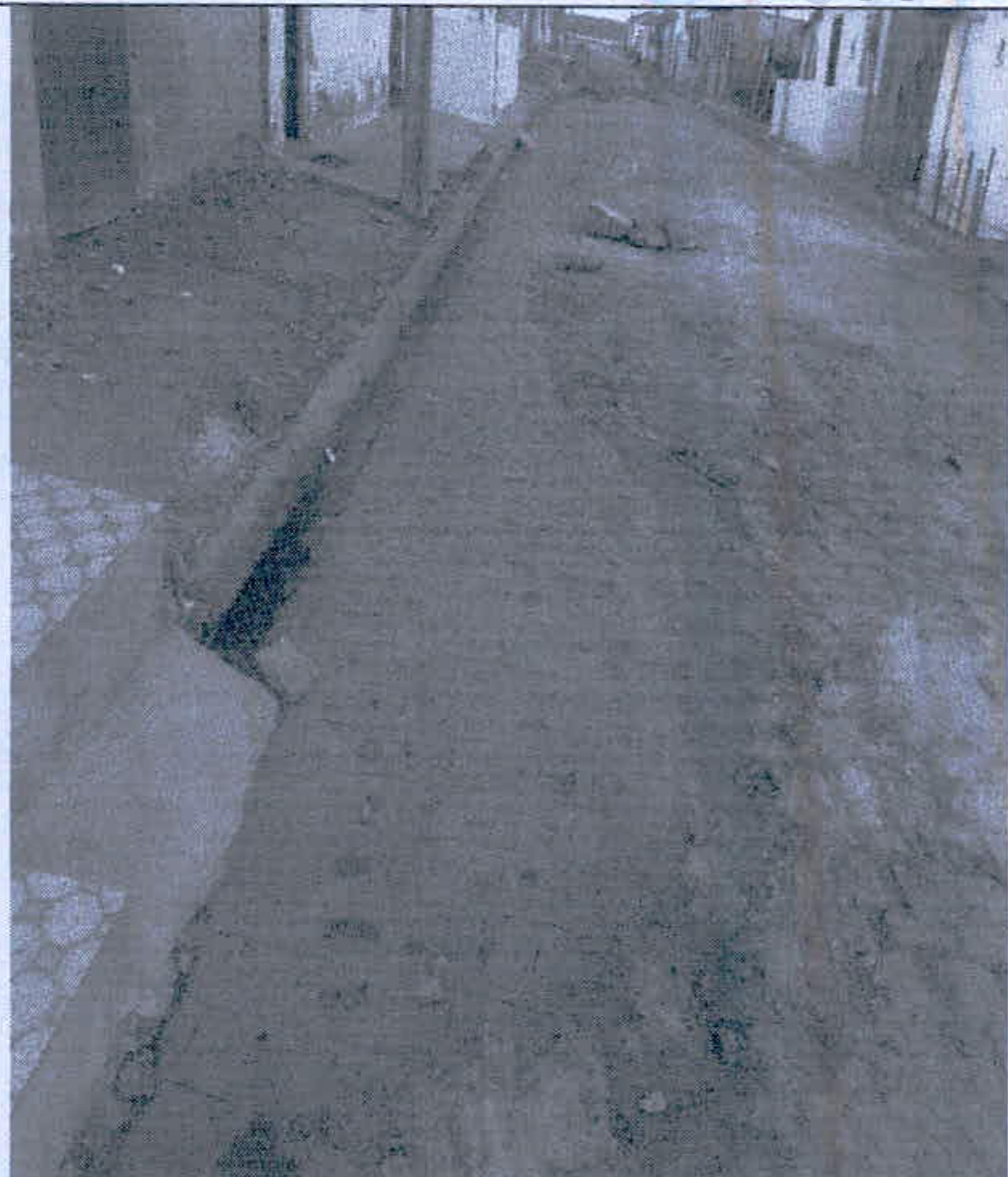
Figura 23 - Loteamento Nossa Senhora das Graças - Pavimento em Paralelepípedo
