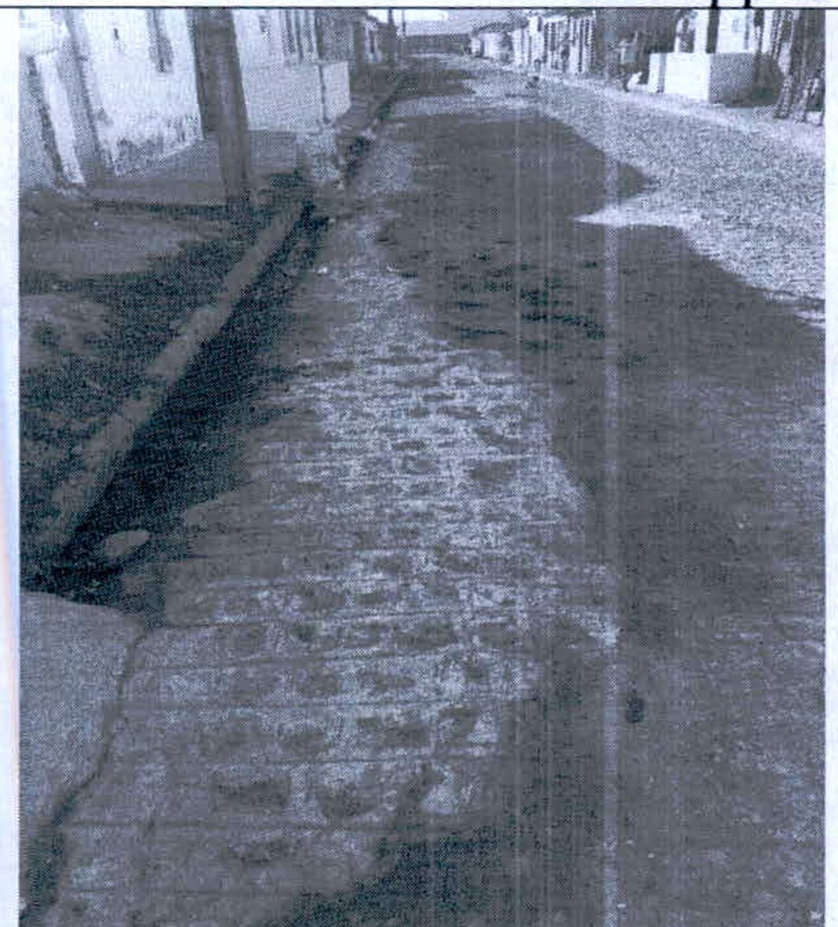
Figura 28 - Loteamento Nossa Senhora das Graças - Pavimento em Paralelepípedo
