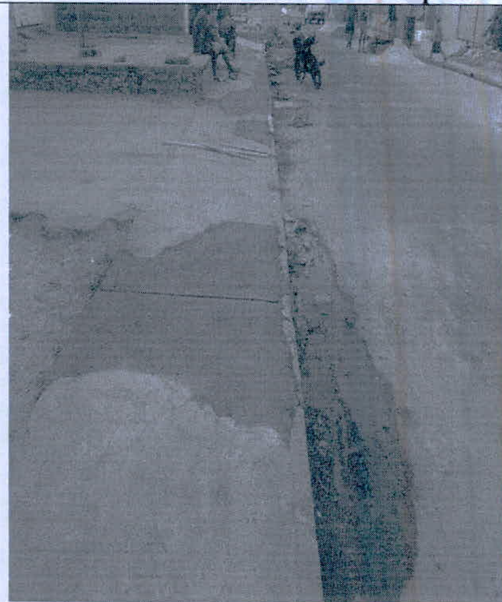
Figura 39 - Rua Petronidio Menezes de Cutia - Demolição de pisos de concreto / Piso de Concreto Desempolado
