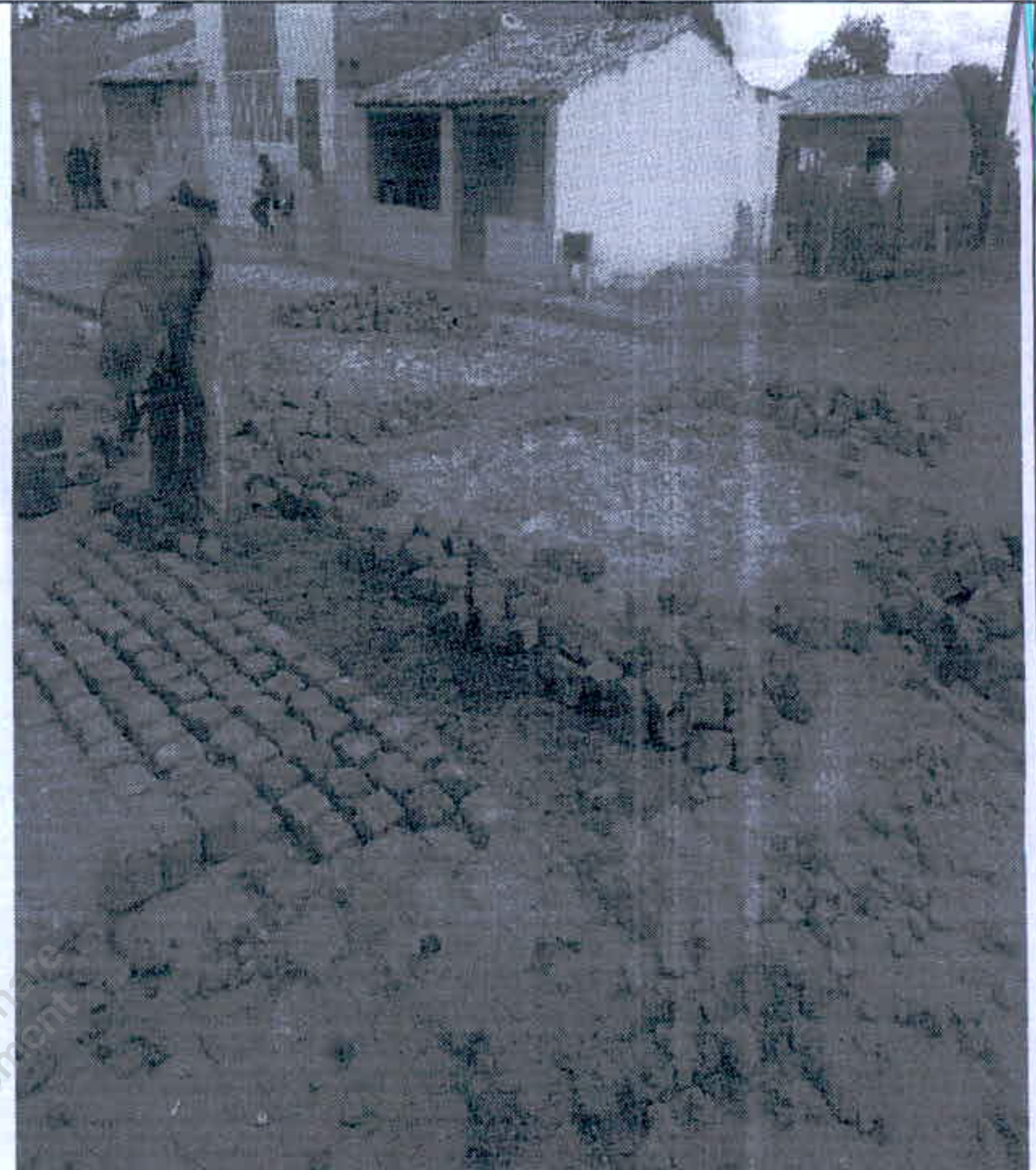
Figura 26 - Figura 23 - Loteamento Nossa Senhora das Graças - Pavimento em Paralelepípedo
