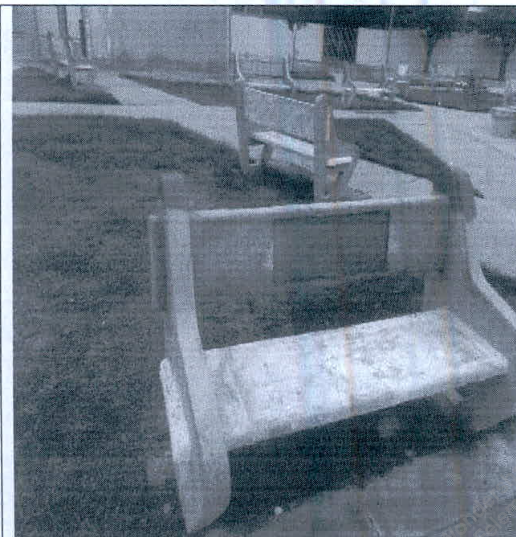
Figura 45 - Avenida Conego M Barbosa – Recuperação de Bancos de concreto
