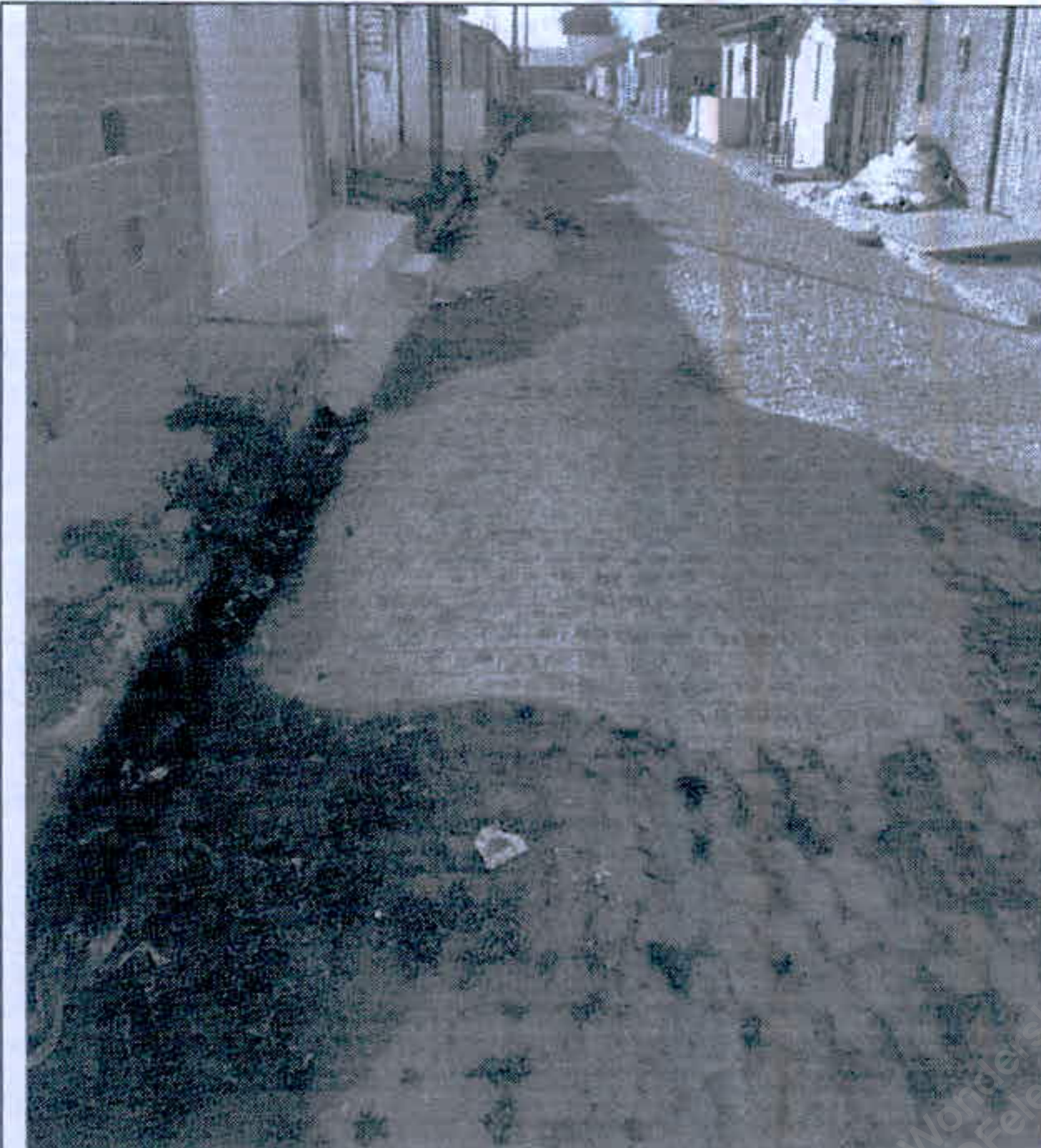
Figura 29 - Loteamento Nossa Senhora das Graças - Pavimento em Paralelepípedo
