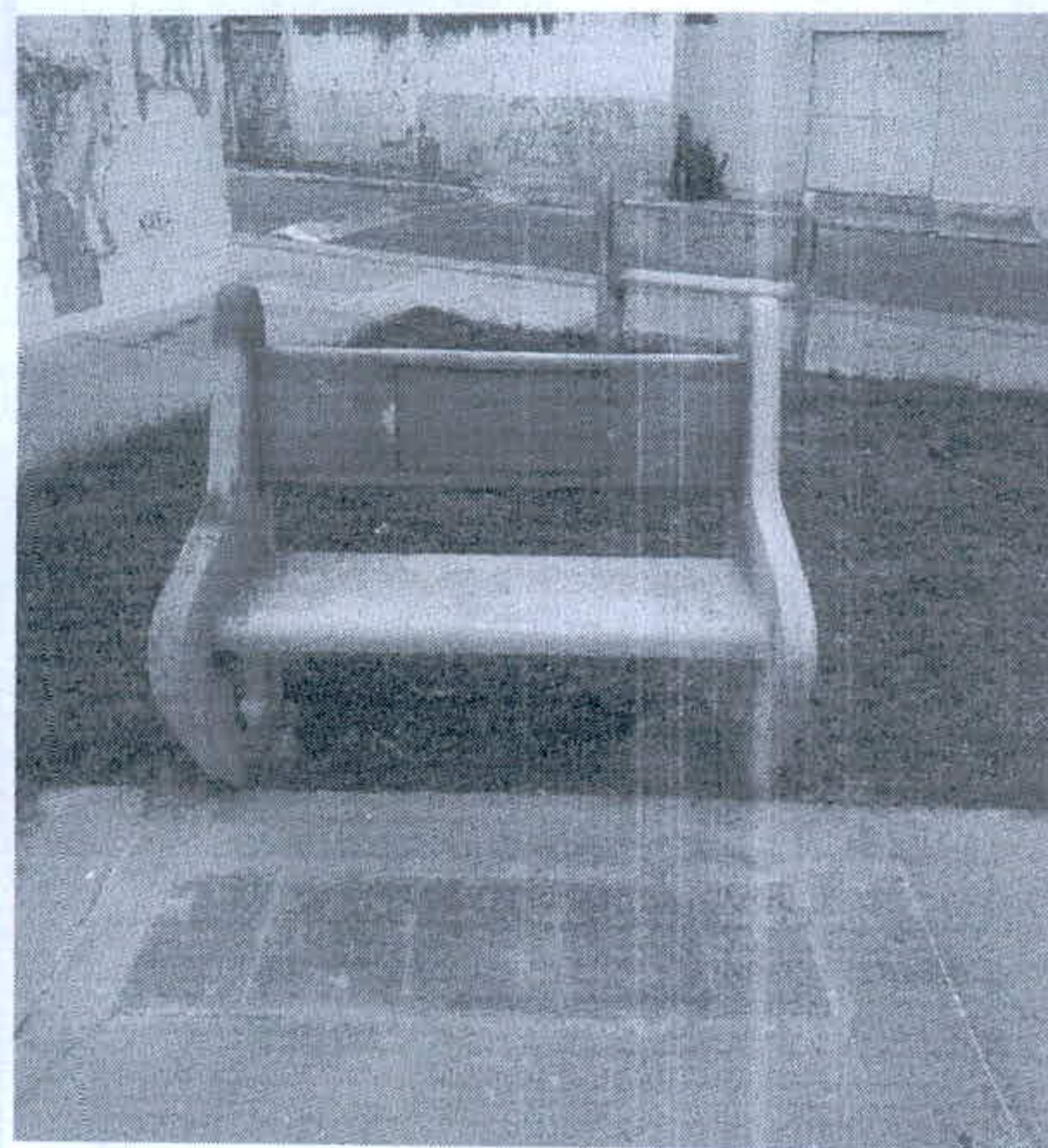
Figura 48 - Avenida Conego M Barbosa - Recuperação de Bancos de concreto
