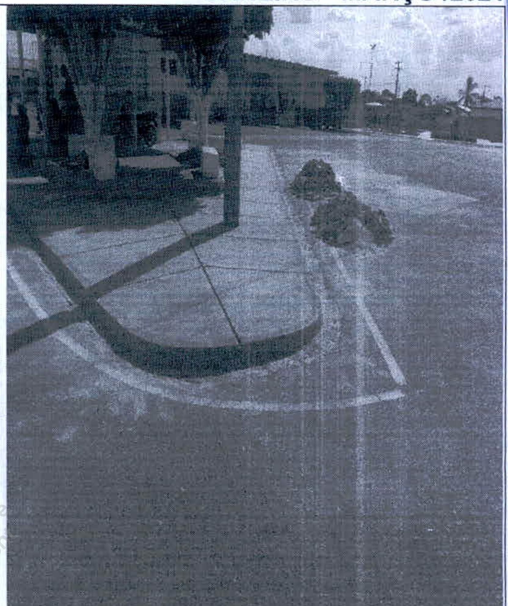
Figura 34 - Avenida Conego Miguel - Demolição de pisos de concreto / Piso de concreto desempolado
