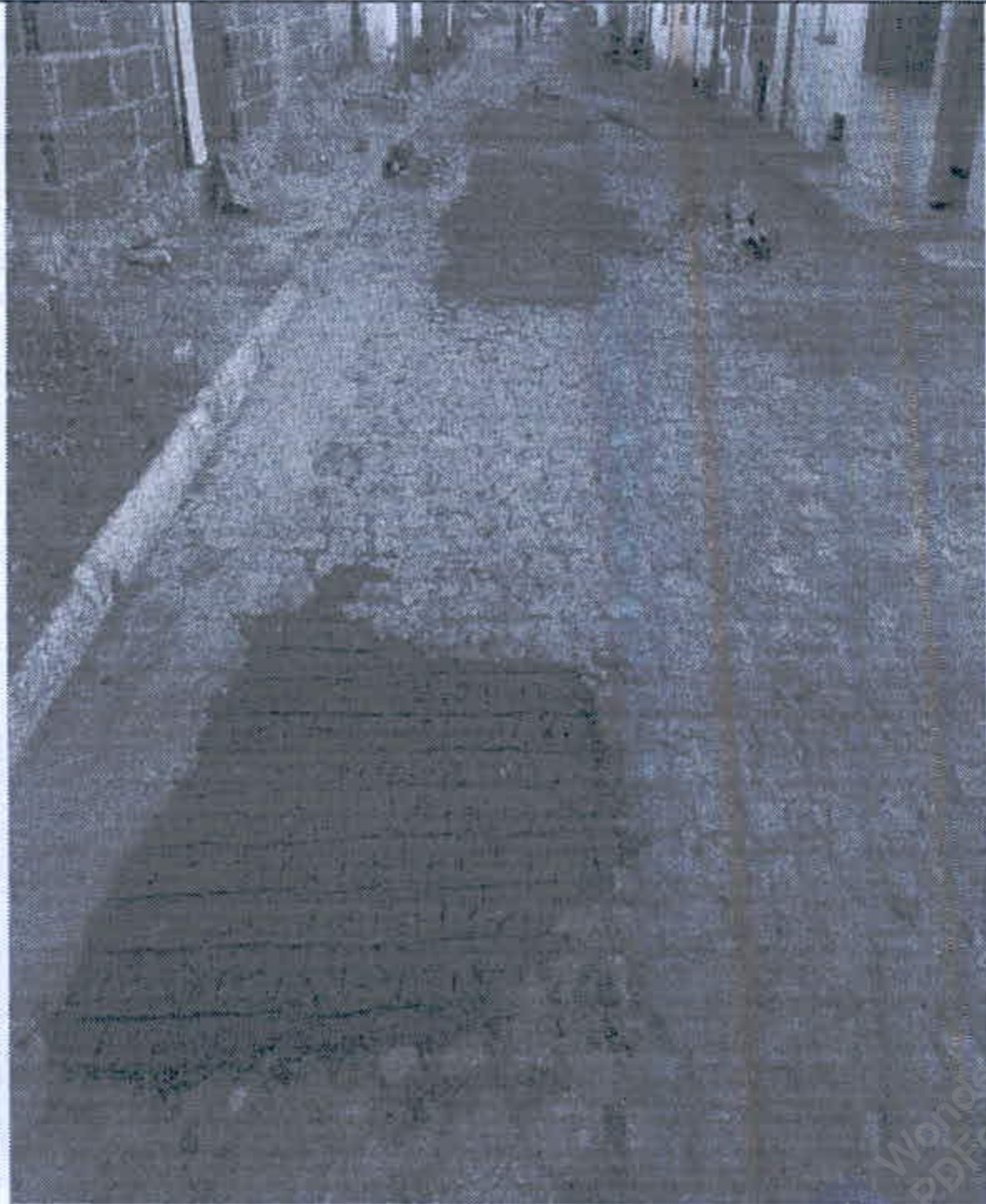
Figura 25 - Figura 23 - Loteamento Nossa Senhora das Graças - Pavimento em Paralelepípedo
