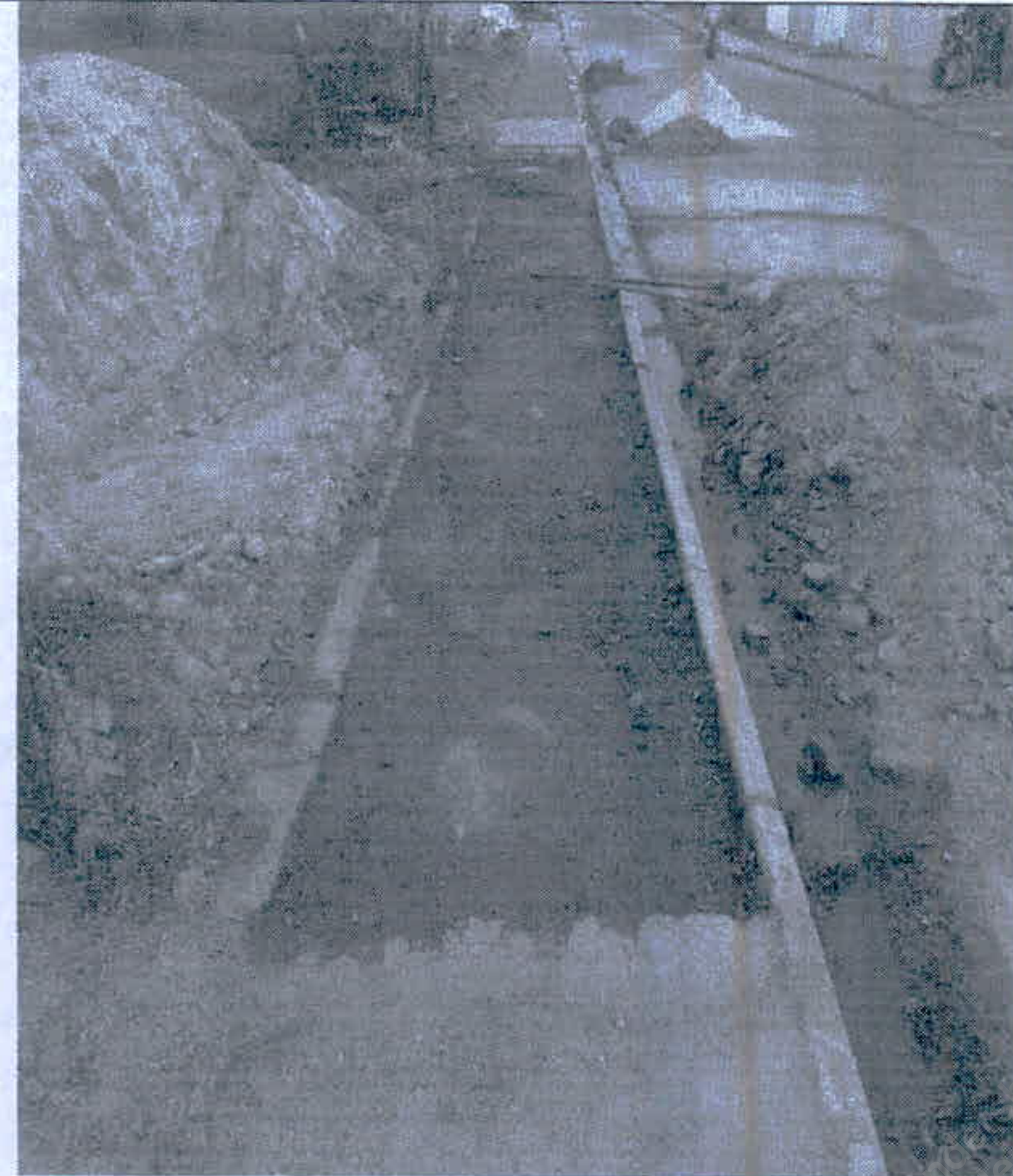
Figura 37 - Rua Petronidio Menezes de Cutia - Demolição de pisos de concreto / Piso de Concreto Desempolado
