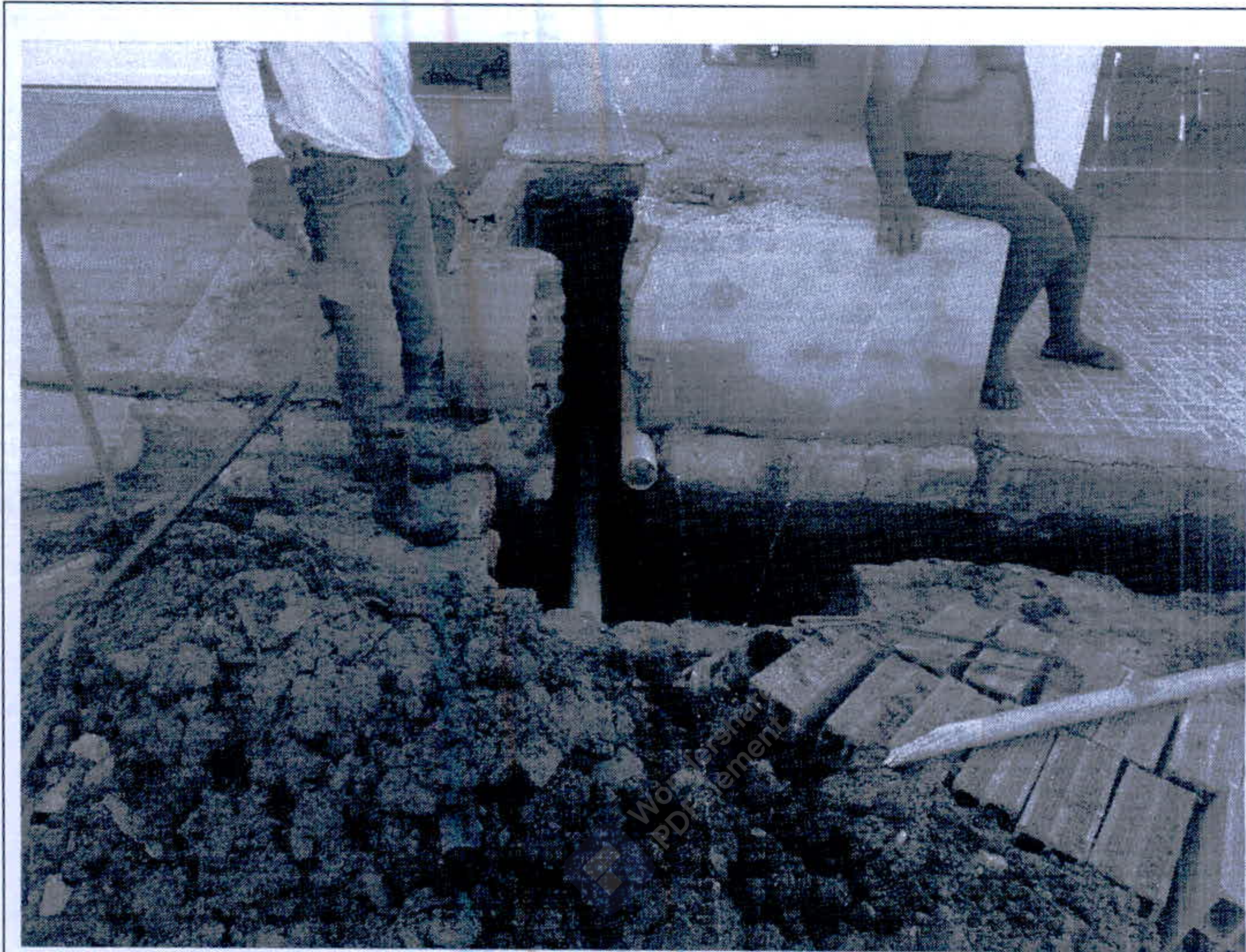
Figura 49 - Rua B do Conj. Nossa Senhora das Graças - Esgotamento sanitário
