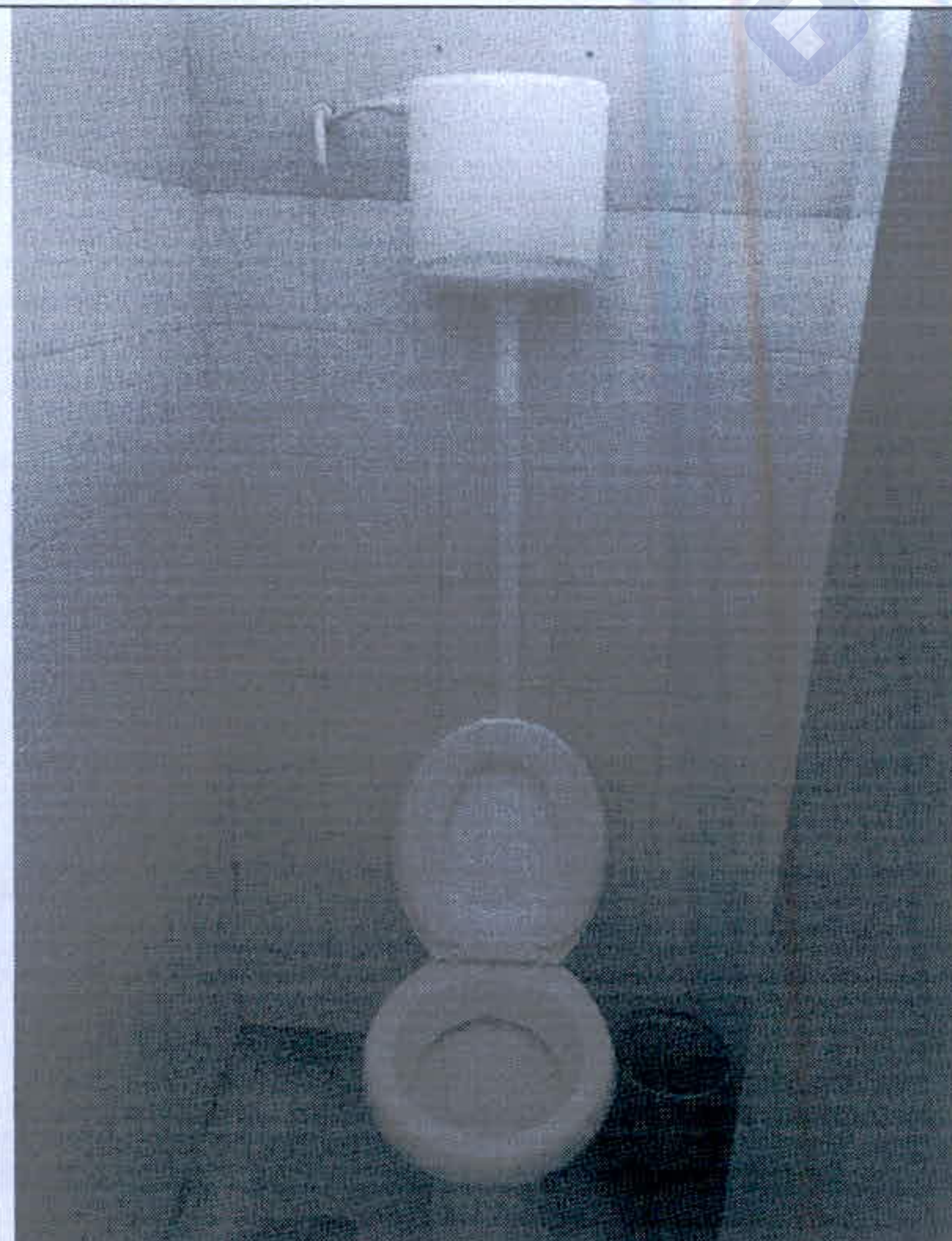
Figura 7 - Ceesa Municipal - Bacia sanitária com Caixa de Descarga / Revisão de ponto de água e esgoto
