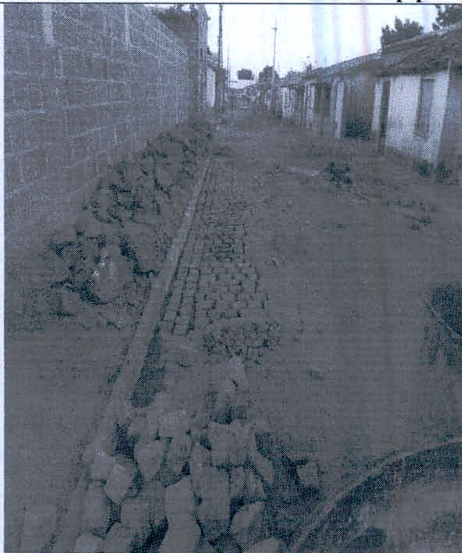
Figura 27 - Loteamento Nossa Senhora das Graças - Pavimento em Paralelepípedo
