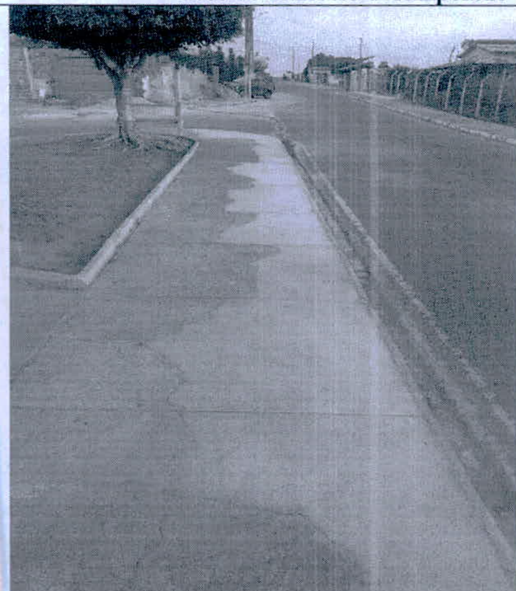
Figura 44 - Rua Petronidio Menezes de Cutia - Demolição de pisos de concreto / Piso de concreto desempolado
