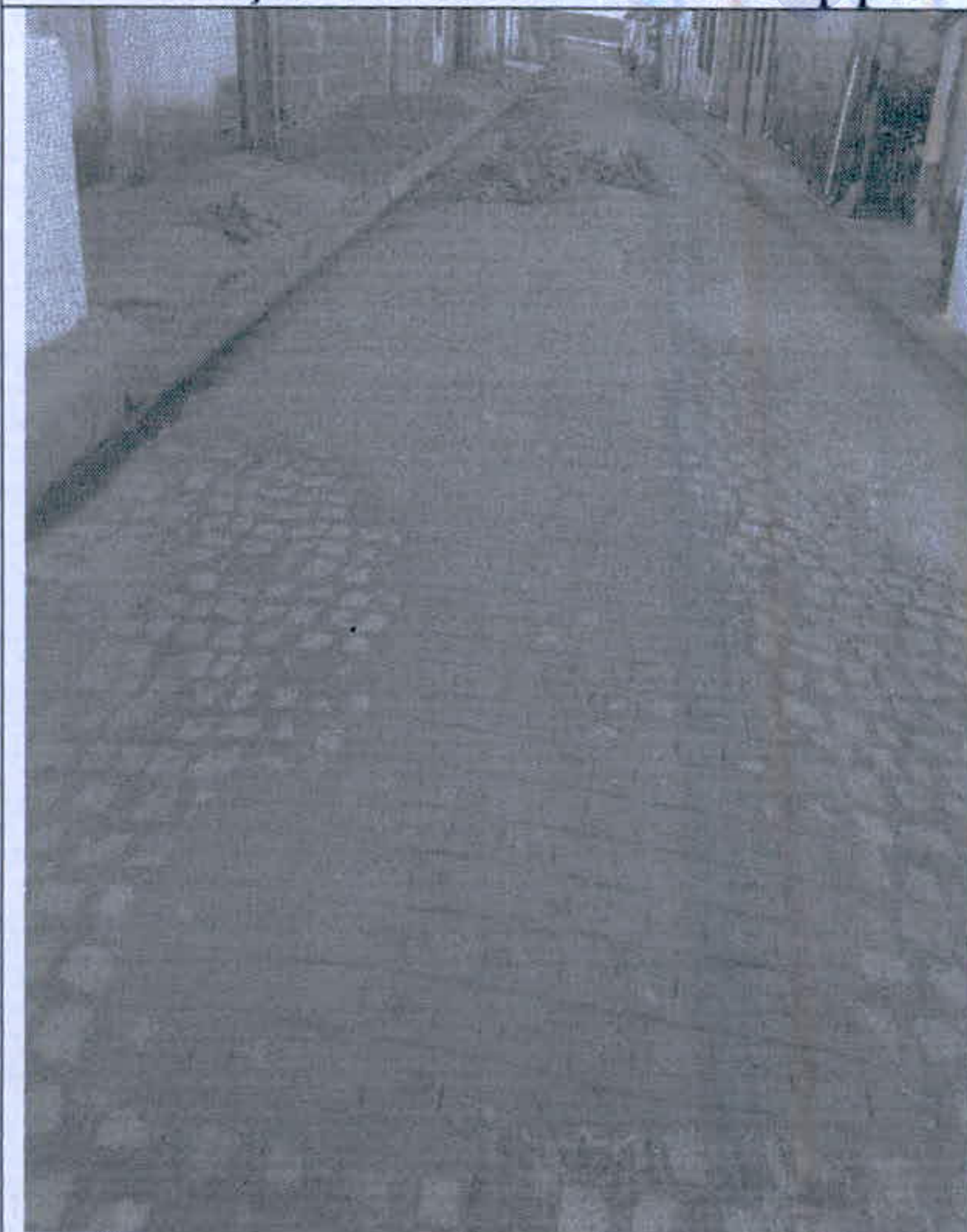
Figura 31 - Loteamento Nossa Senhora das Graças - Pavimento em Paralelepípedo
