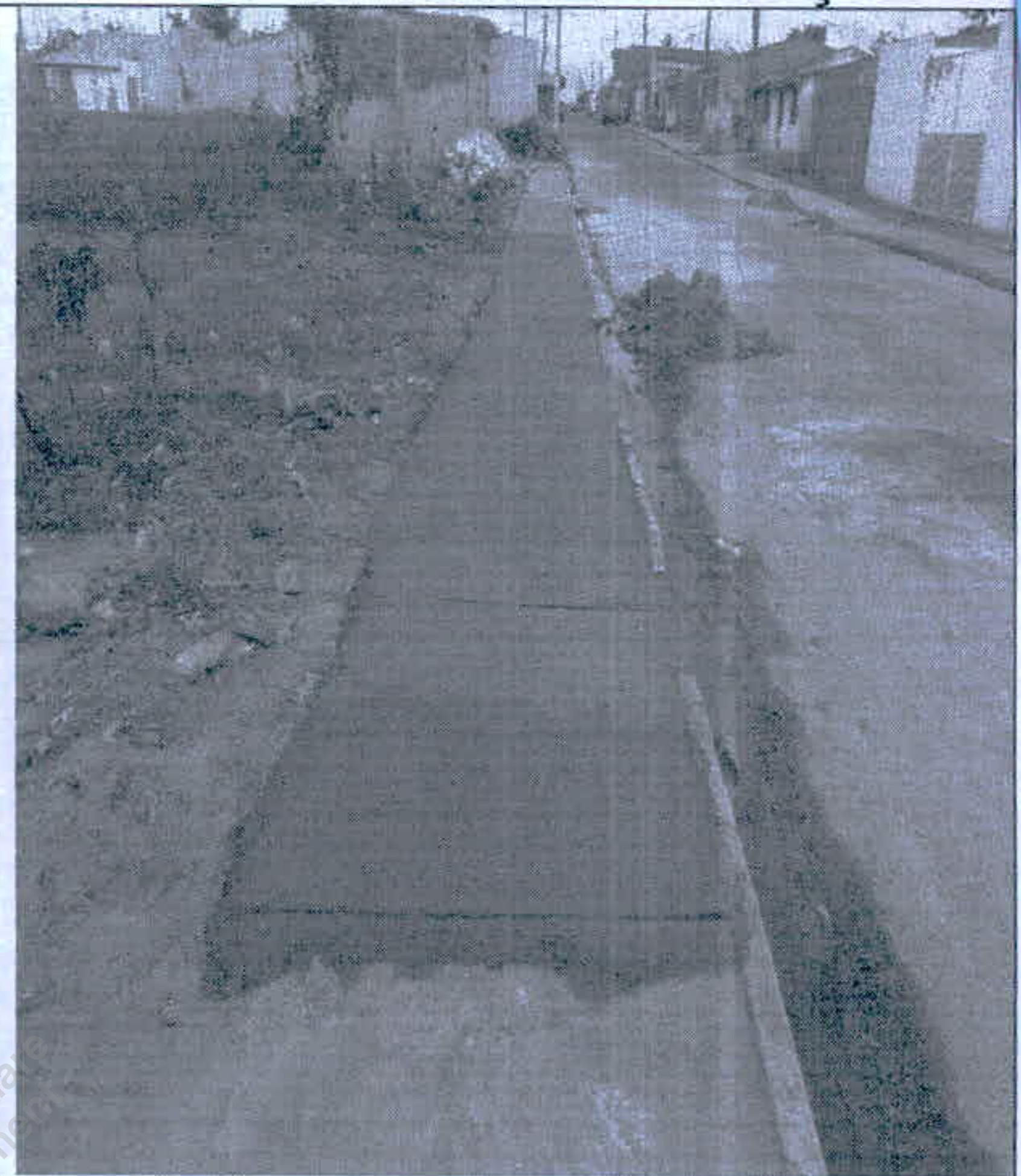
Figura 38 - Rua Petronidio Menezes de Cutia - Demolição de pisos de concreto / Piso de Concreto Desempolado
