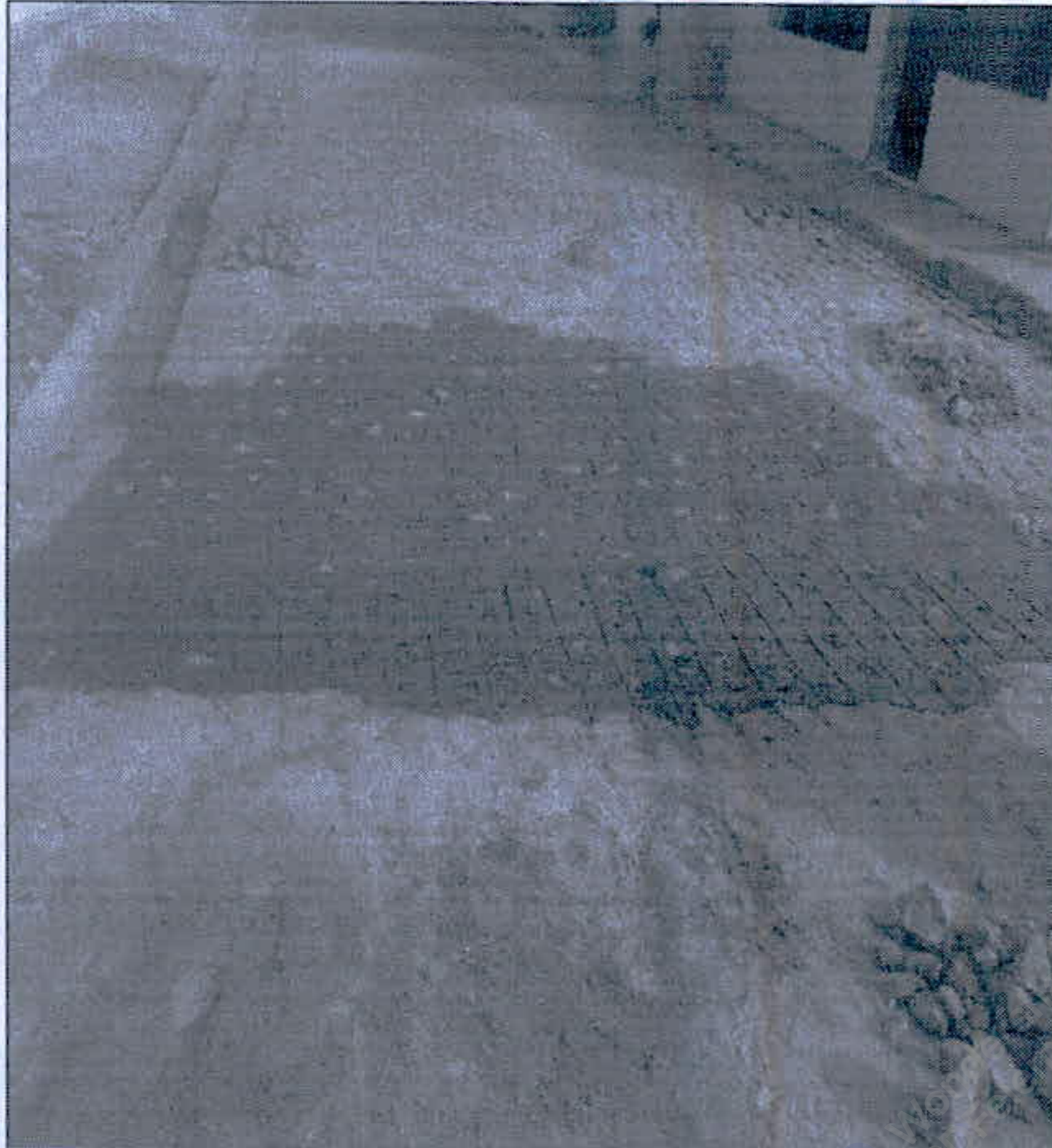
Figura 21 - Loteamento Nossa Senhora das Graças - Pavimento em Paralelepípedo
