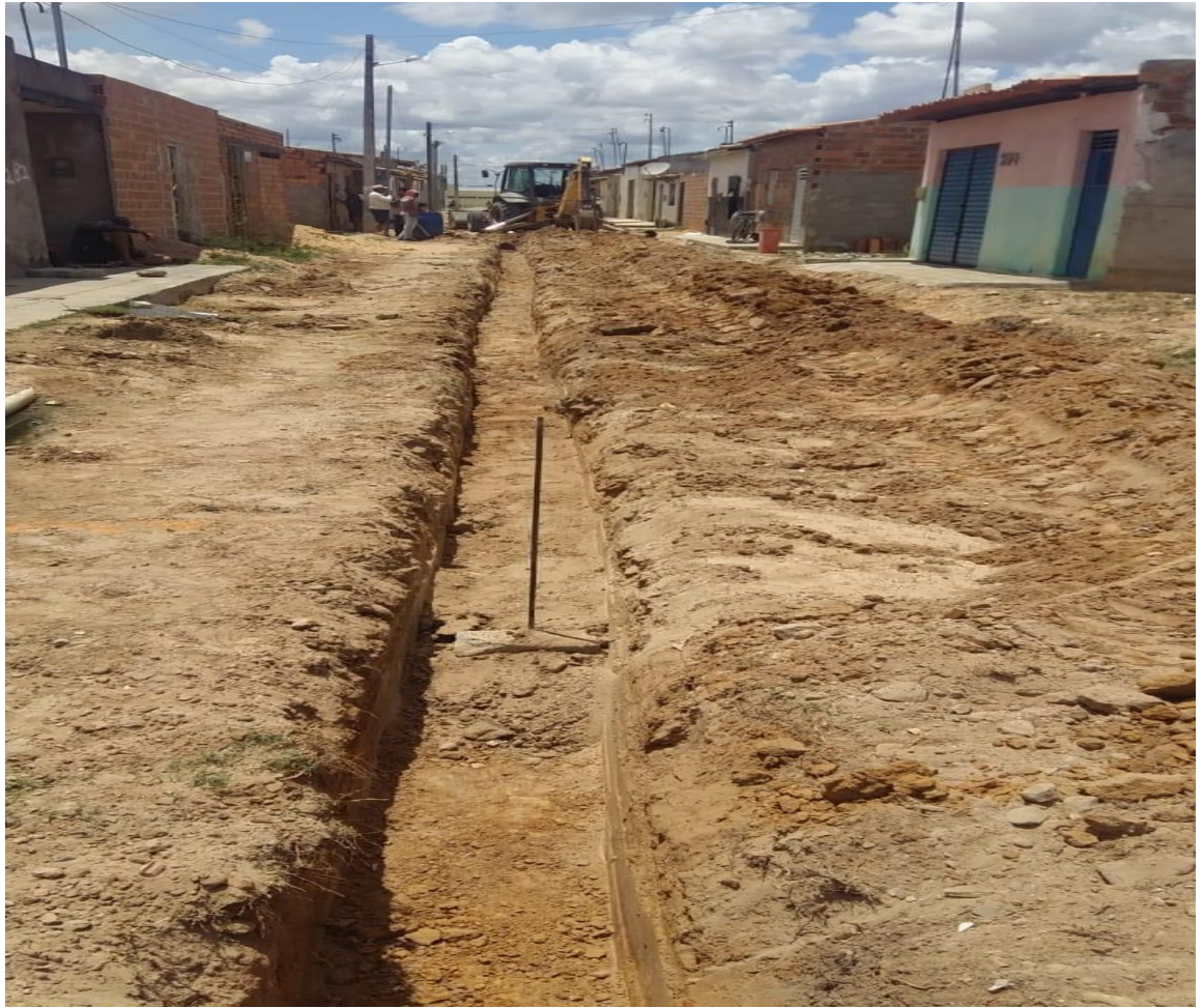
Rua Ampliação da rede de esgoto na Rua João Santos da Silva, Conjunto Irmã
