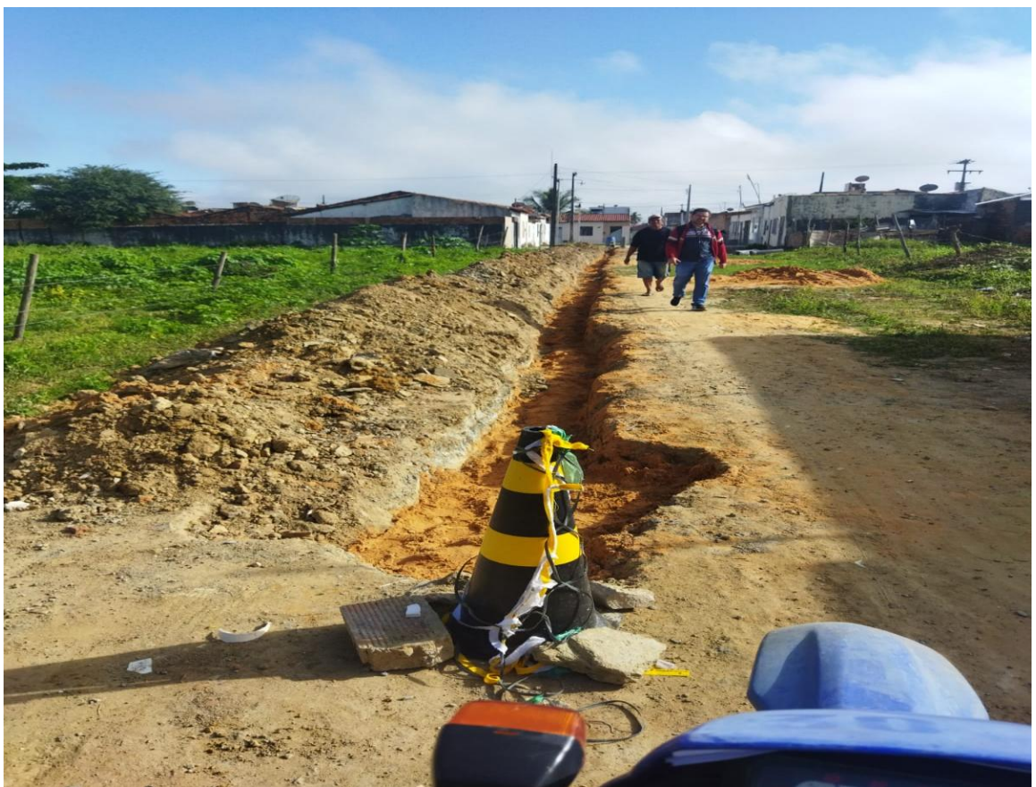
Ampliação da rede de esgoto na Rua Elias Felipe, Bairro Centro
