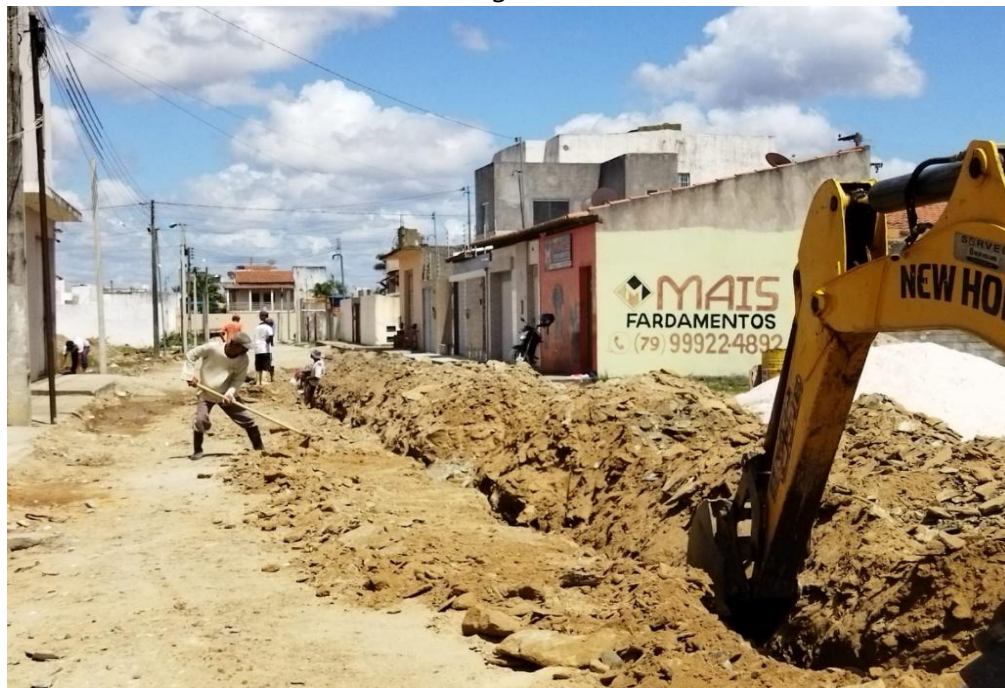
Ampliação de rede de esgoto na Rua João Batista dos Santos, Bairro Macaé
