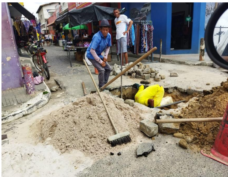
Desobstrução De Rede De Esgoto Na Travessa Santa Luisa
