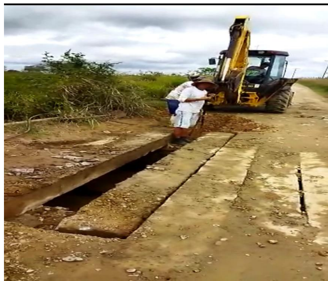
Figura 1 REPAROS NA PONTE DO POVOADO BARRIGA
