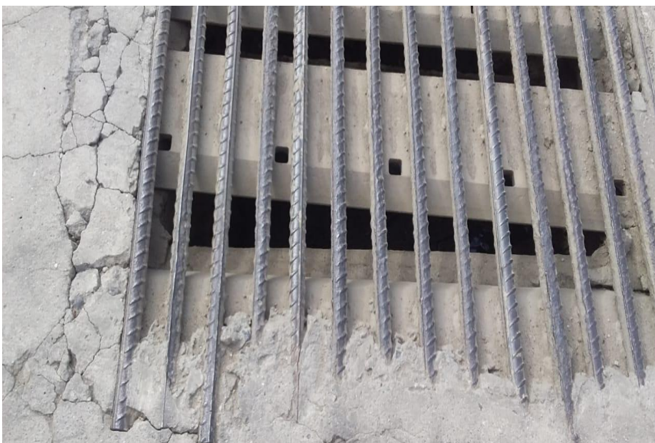
Colocação De Grades Em Boca De Lobo
