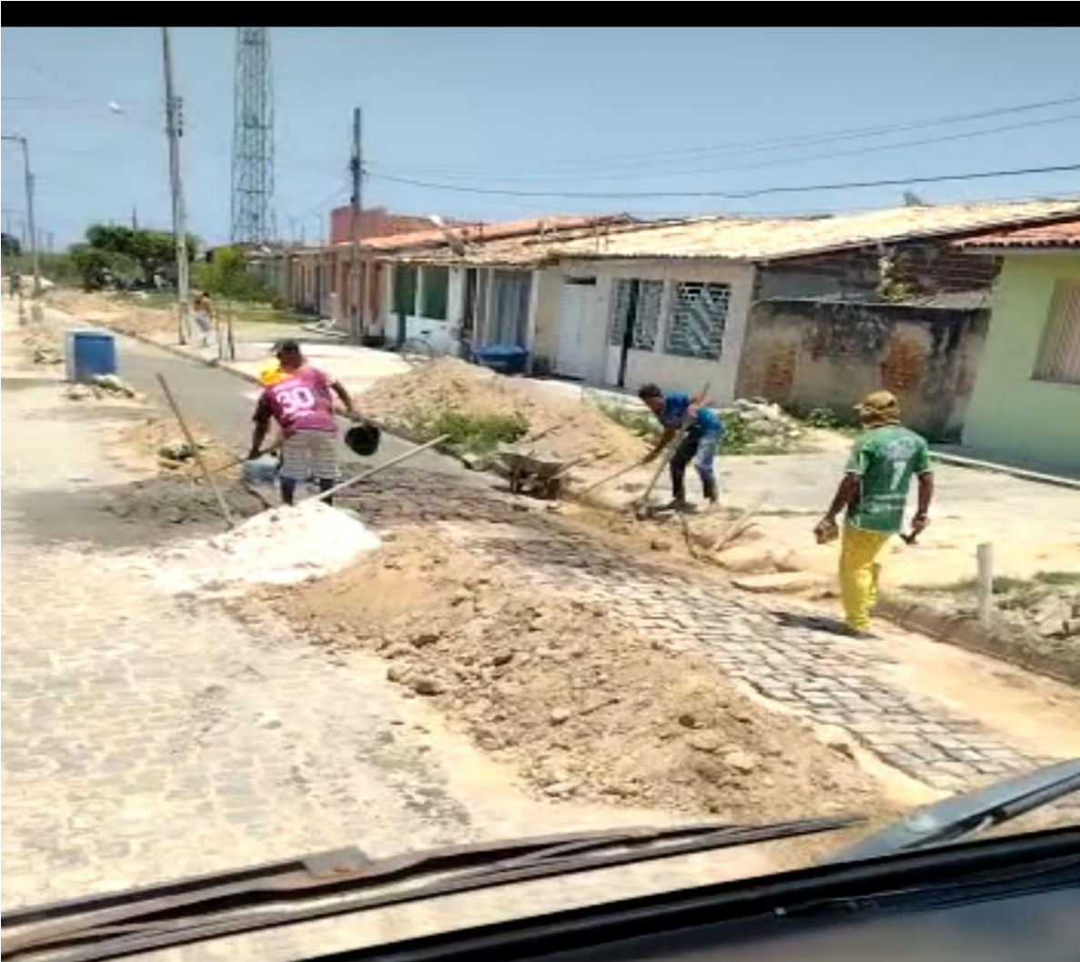
Ampliação de rede de esgoto no Povoado Barriga.
