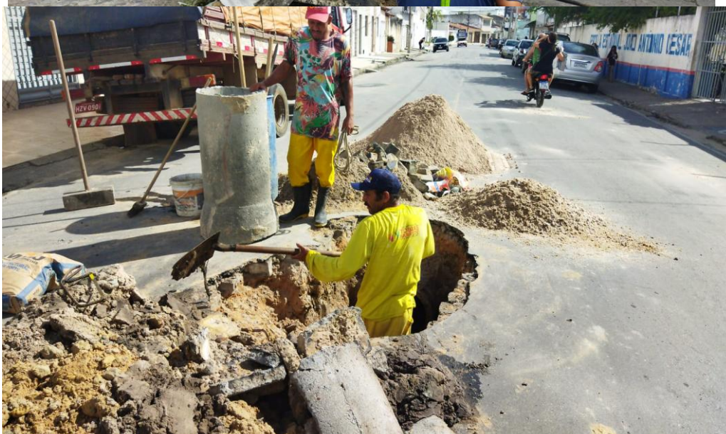
Desobstrução De Rede De Esgoto Na Rua Carlos Lemos
