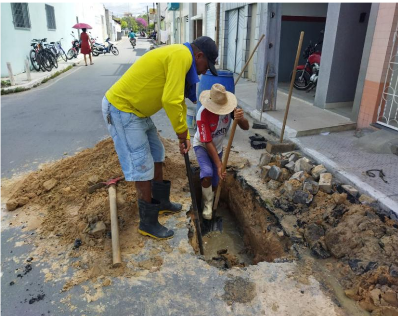
Desobstrução De Rede De Esgoto Na Travessa Silvio Romero
