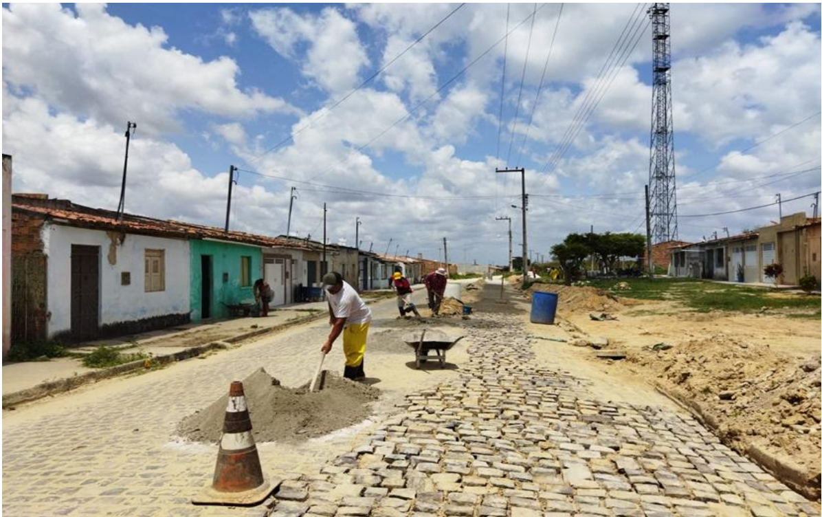
Ampliação da rede de esgoto Povoado Barriga
