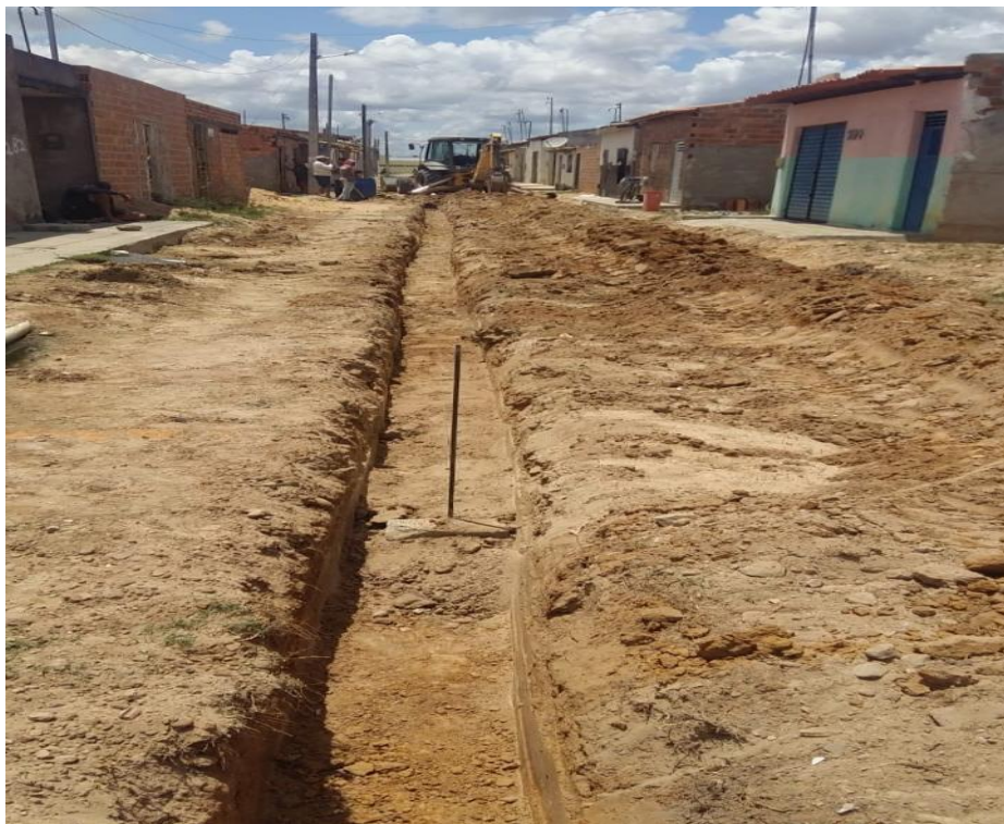
Ampliação da rede de esgoto na Rua João Batista dos Santos, Bairro Macaé
