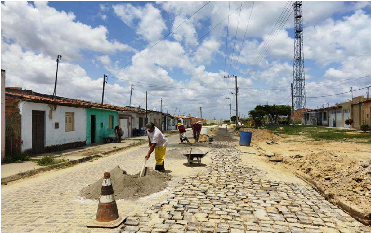
Ampliação da rede de esgoto Povoado Barriga
