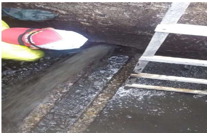
Colocação De Grades Em Boca De Lobo
