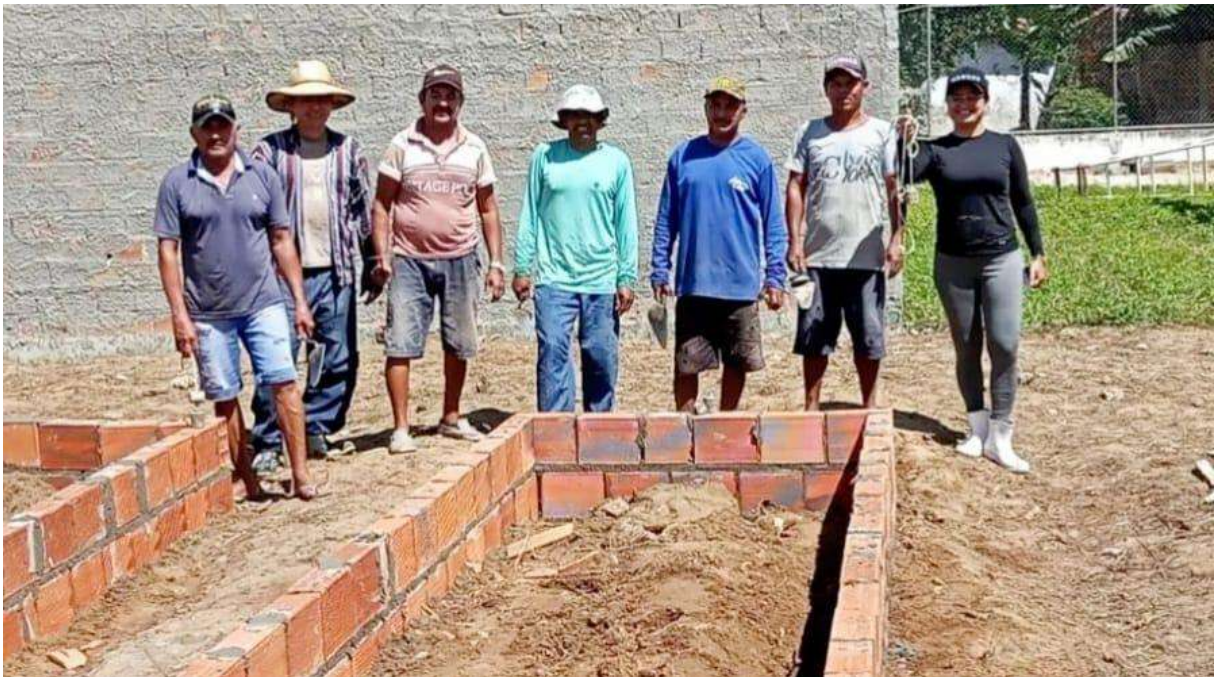
Construção de uma Horta na EMEF Pedro Izídio de Oliveira
