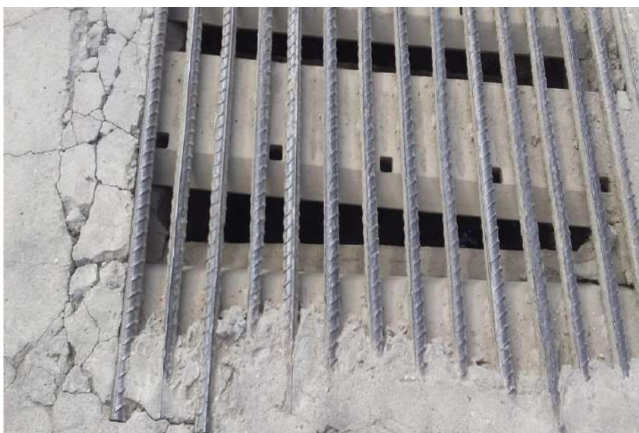
Colocação De Grades Em Boca De Lobo
