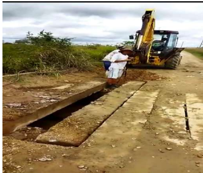
Figura 1 REPAROS NA PONTE DO POVOADO BARRIGA
