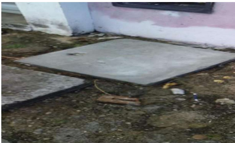
Colocação De Tapa Em Caixa De Esgoto No Conjunto Habitacional Agripino Bernardo I
