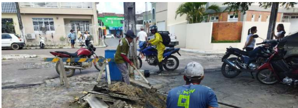
Desobstrução De Rede De Esgoto Na Avenida Cel Francisco Barreto
