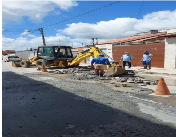
RECUPERAÇÃO REDE DE ABASTECIMENTO DE ÁGUA EM PARCERIA COM A DESO
