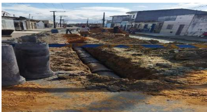
AMPLIAÇÃO DE REDE DE ESGOTO NA RUA JOSÉ ROSA DE OLIVEIRA
