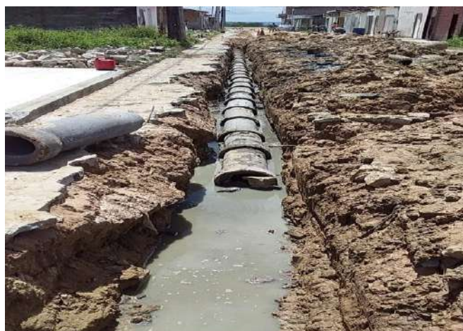
EXTENSÃO DE REDE DE ESGOTO NA RUA JOSÉ CUPERTINO DE ANDRADE, CONJUNTO PADRE PEDRO.
