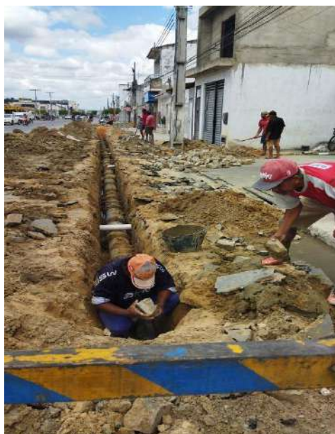
RUA JOSÉ ALVES DA SILVA, EXTENSÃO DE REDE DE ESGOTO
