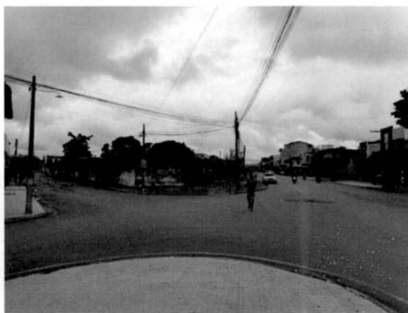
Foto 02. Cruzamento da Rua José David dos Santos com a Rua Carlos Lemos e Rua José Felipe.
