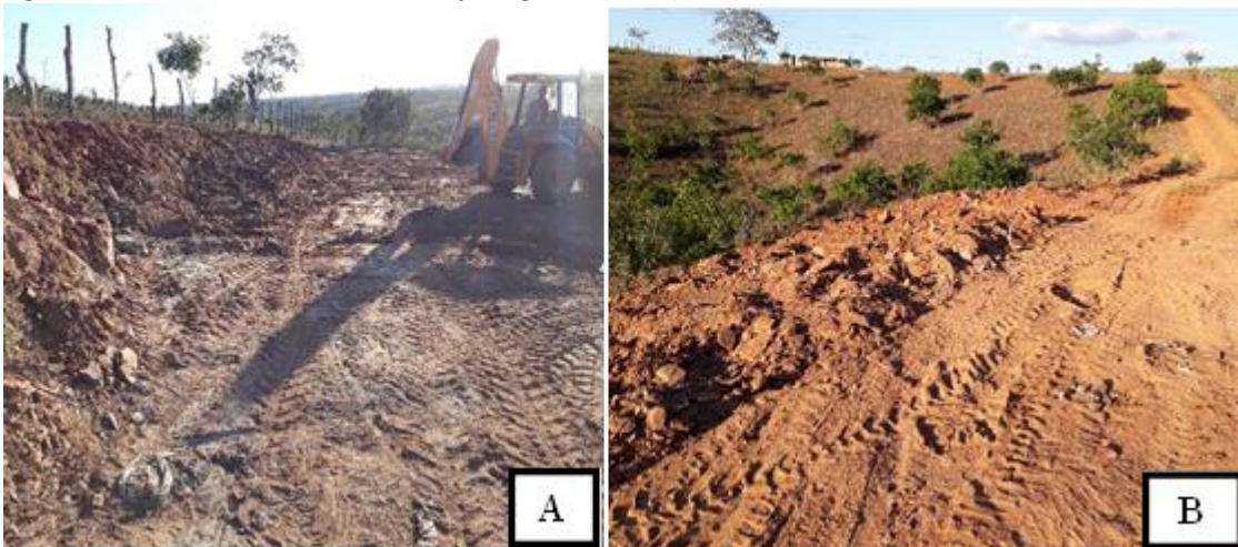
Figura 80 - Retirada de todo o lixo e terraplanagem da área. (A e B)
