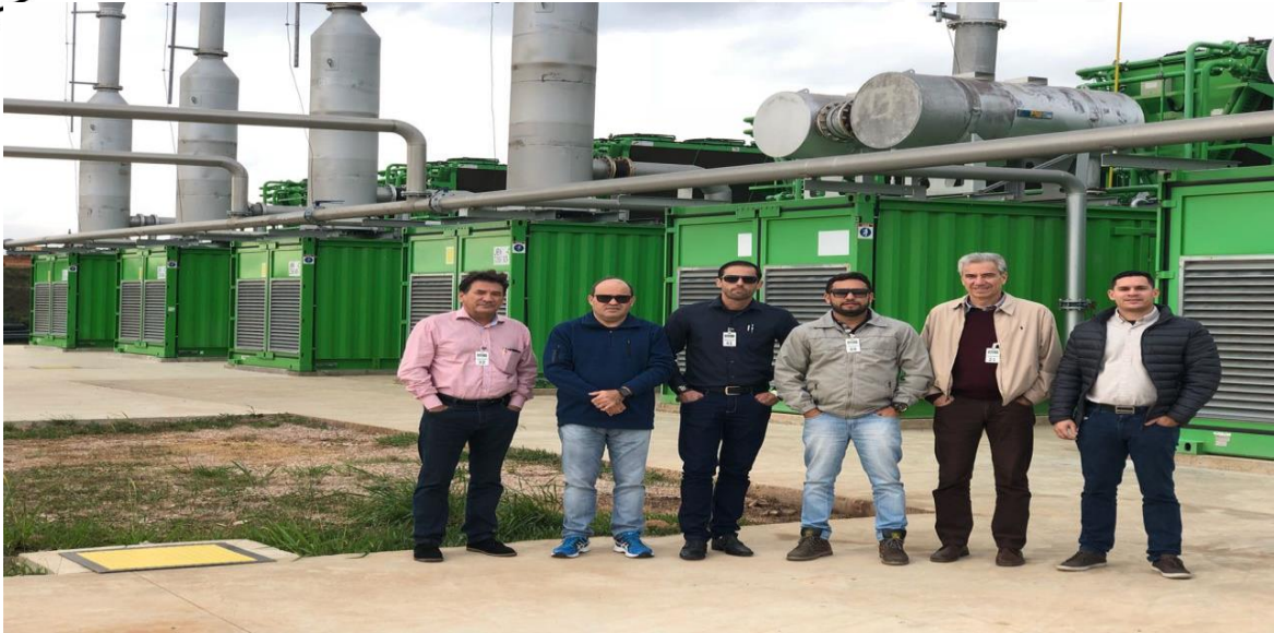
Figura 86 - Visita ao CGR – Iguaçu, do aterro sanitário da Estre Ambiental.
