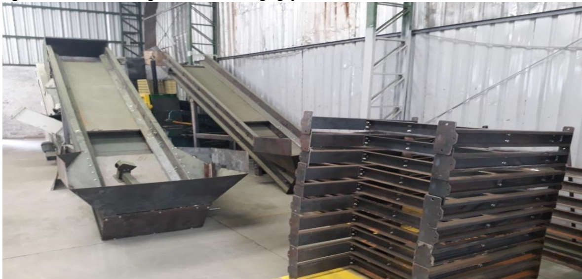
Figura 91 - Linha de montagem da esteira de segregação da NKS.
