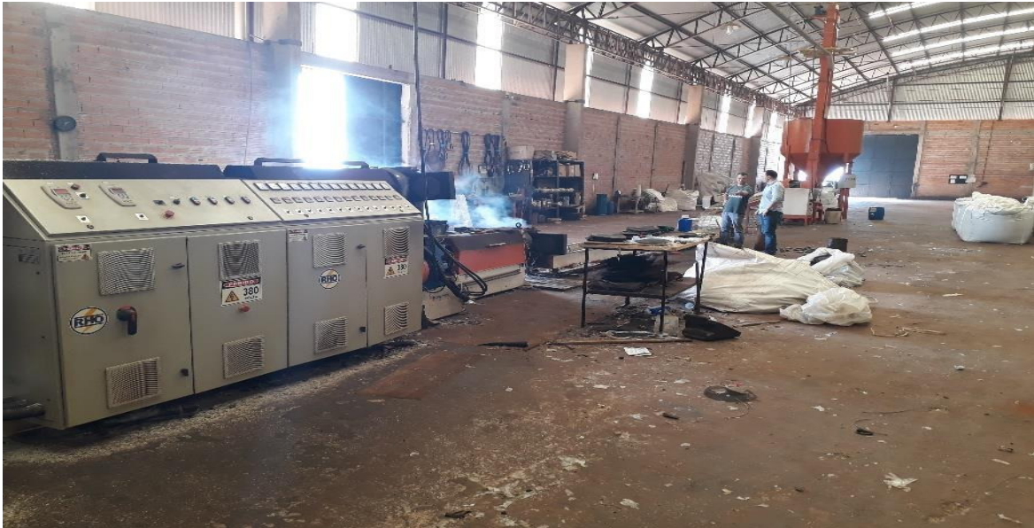
Figura 89 - Visita à empresa de materiais recicláveis, que atualmente opera um dos equipamentos Londrina/PR.
