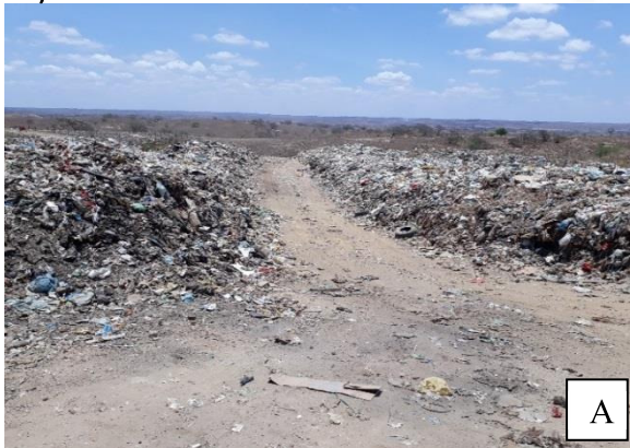
Figura 81 - Liberação das vias de acesso do entorno do lixão pelo remanejamento da massa de lixo disposta na área (A e B).
