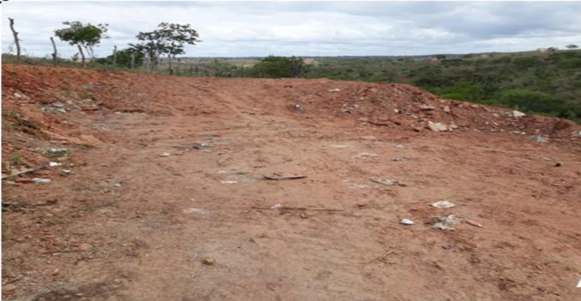
Figura 79 - Área que houve o recobrimento dos resíduos retirados de forma parcial.
