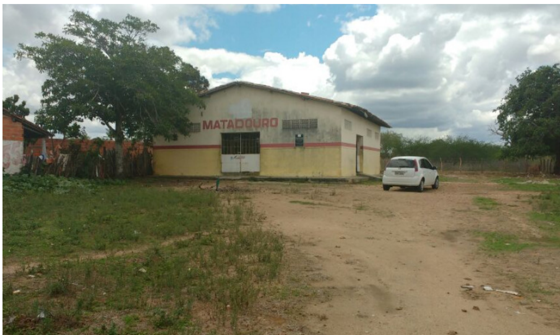
Figura 31: Prédio do antigo Matadouro, atualmente desativado. O município de Gracho Cardoso possui pretensões de utilização e adaptações do prédio para instalação de galpão de segregação de materiais recicláveis. CONBASF, 2018.
