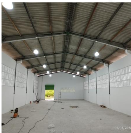
Figura 49: : Parceria com o Ministério Público do Trabalho (MPT) – Galpão reformado. Fonte: CONBASF, 2023.
