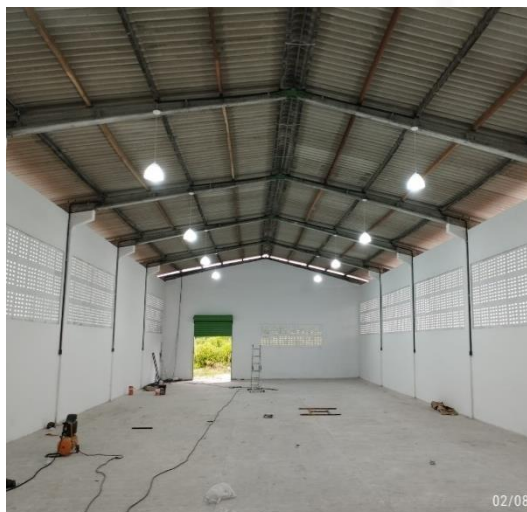
Figura 53: Parceria com o Ministério Público do Trabalho (MPT) – Galpão reformado. Fonte: CONBASF, 2023.
