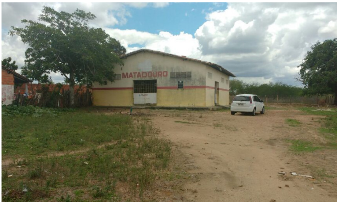
Figura 31: Prédio do antigo Matadouro, atualmente desativado. O município de Gracho Cardoso possui pretensões de utilização e adaptações do prédio para instalação de galpão de segregação de materiais recicláveis. CONBASF, 2018.
