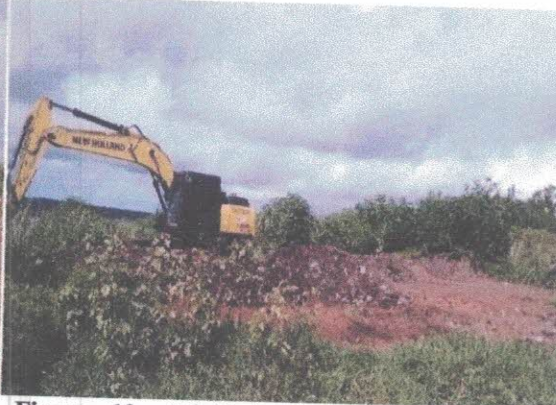
Figura 12: Atividade de campo, início das atividades para descontaminação do lixão de São Francisco. Fonte: CONBASF, 01/07/2021.
