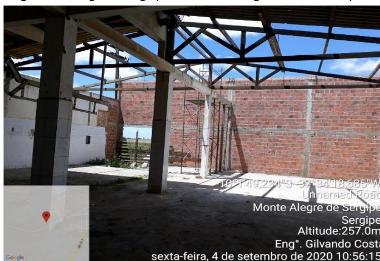
Figura 38 – Registro do galpão de Monte Alegre com as obras paralisadas
