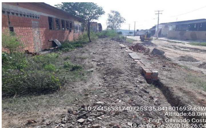
Figura 54 – Vista ao galpão da cerâmica Amorim.
