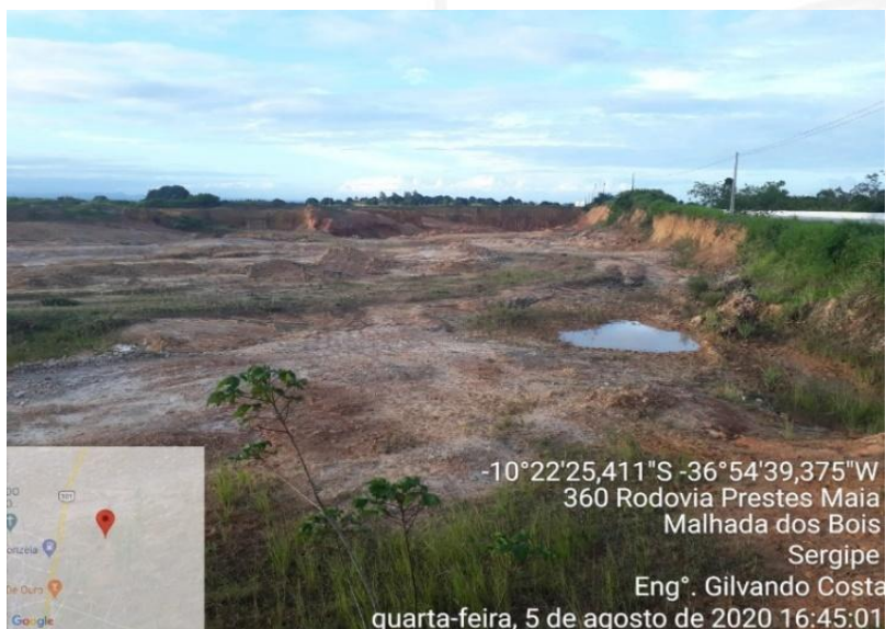
Figura 31 – Vistoria em terreno da empresa de Cerâmica Amorim.
