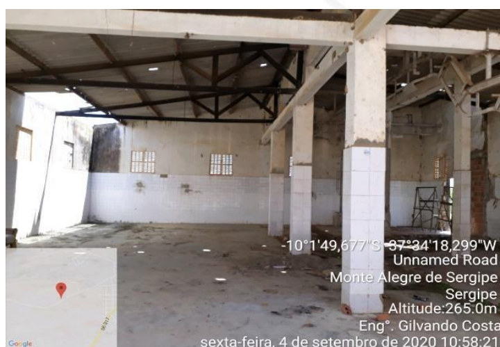
Figura 25 – Registro do galpão de Monte Alegre com as obras paralisadas.
