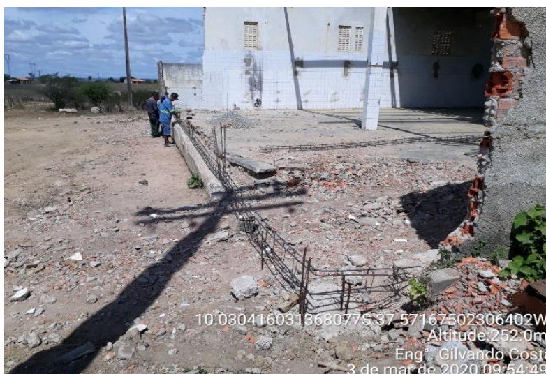
Figura 34 - Visita técnica em matadouro de Monte Alegre.
