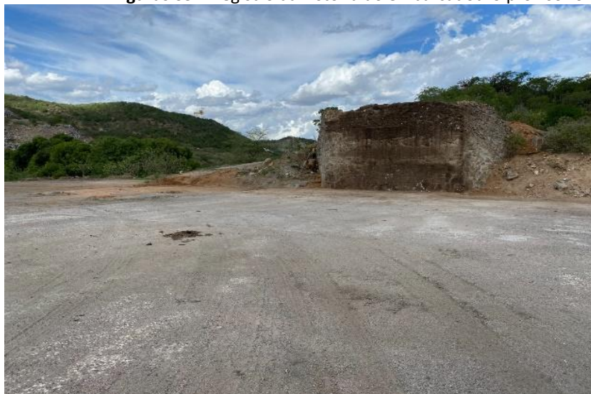
Figuras 03 – Registro da vistoria do embarcadouro provisório.
