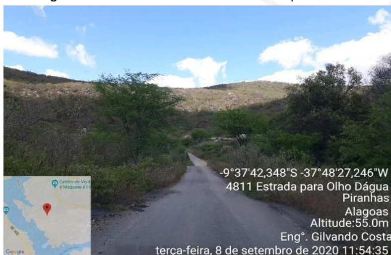
Figura 14 – Vistoria na área do embarcadouro provisório.
