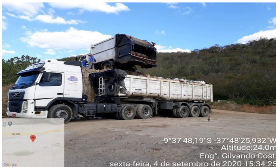
Figura 11 – Vistoria a área do embarcadouro de Canindé de São Francisco
