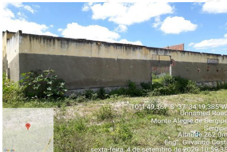
Figura 37 – Registro do galpão de Monte Alegre com as obras paralisadas.
