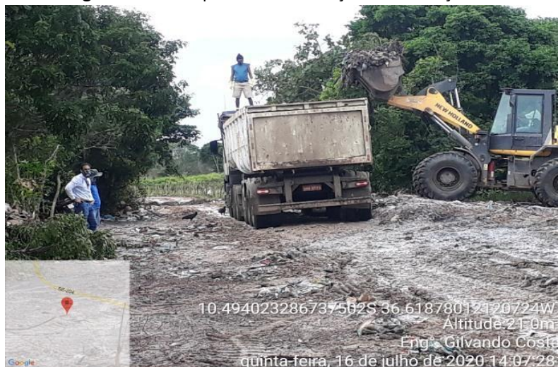
Figura 50 – Acompanhamento das ações de execução do PRAD.
