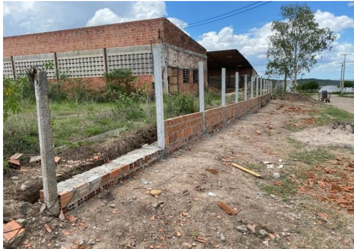
Figura 53 – Vista ao galpão da cerâmica Amorim.
