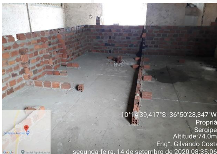
Figura 55 – Vista ao galpão da cerâmica Amorim
