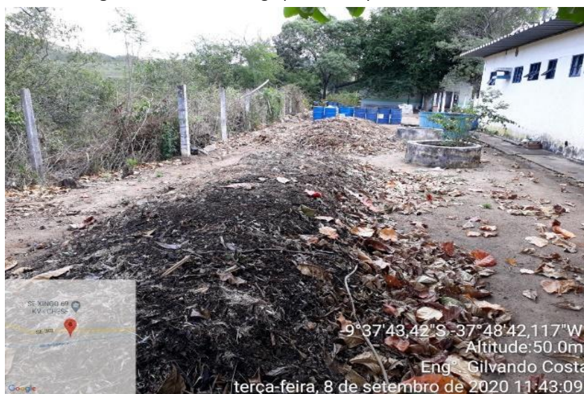
Figura 15 – Vistoria no galpão da cooperativa SE-PA-RE.
