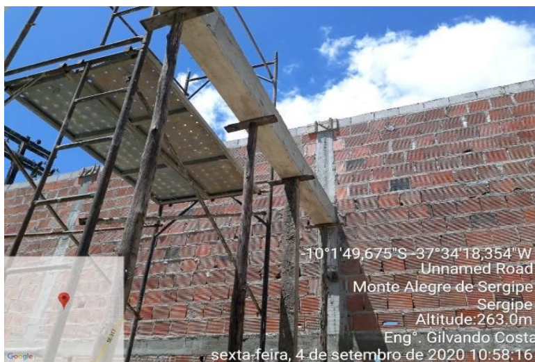
Figura 36 – Registro do galpão de Monte Alegre com as obras paralisadas.
