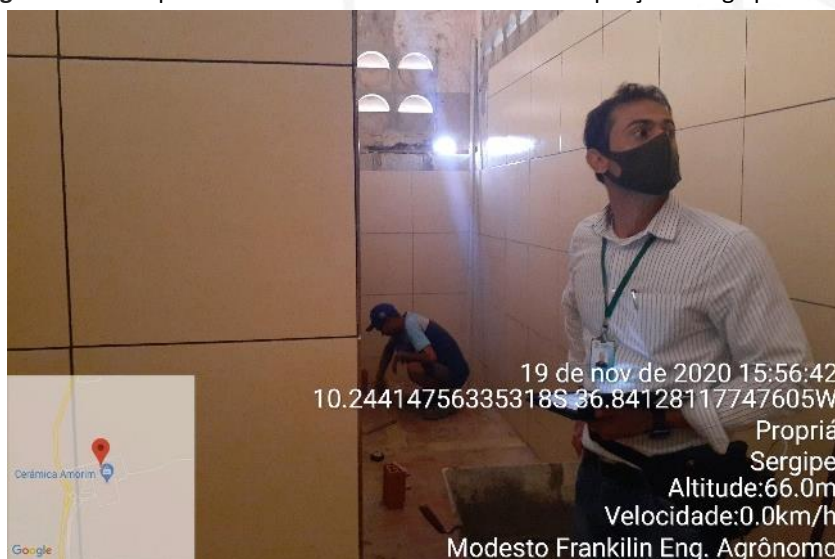
Figura 56: Acompanhamento das obras de reforma e ampliação dos galpões de Própria.
