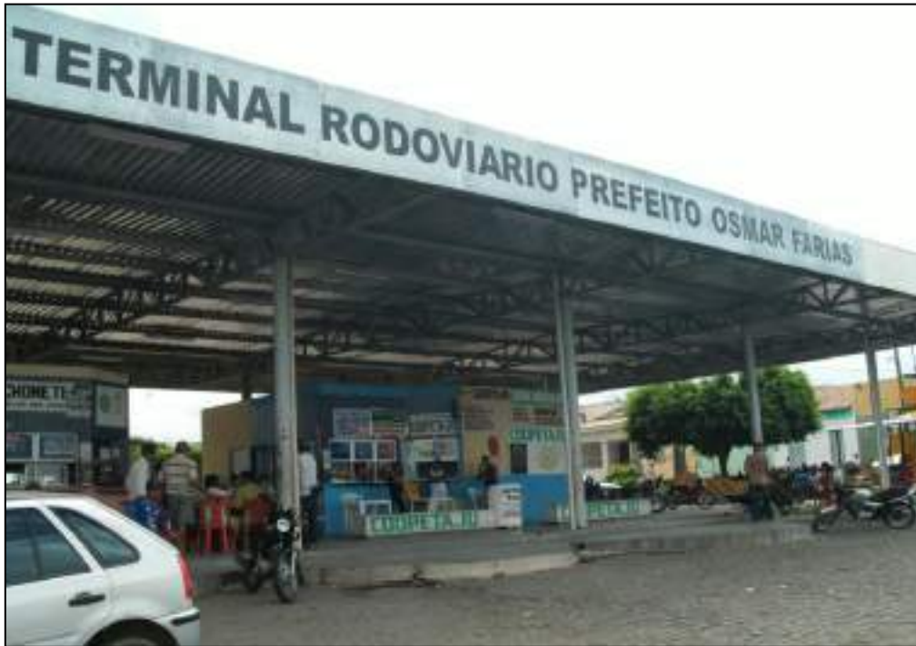
Figura 38: Terminal rodoviário – Monte Alegre de Sergipe/SE.
