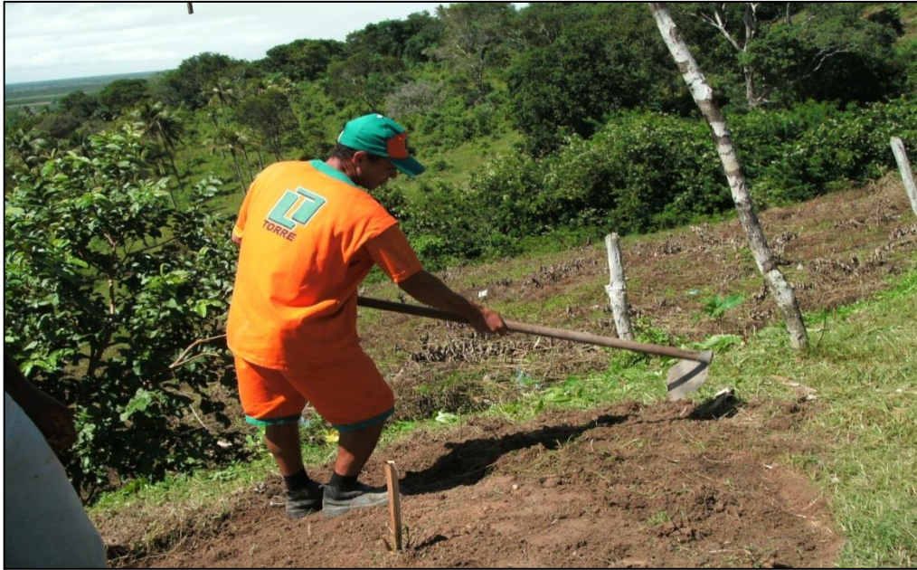
Figura 51: Serviço de capina manual – Pacatuba/SE. Crédito da foto: Trabalho de Campo/2010.
