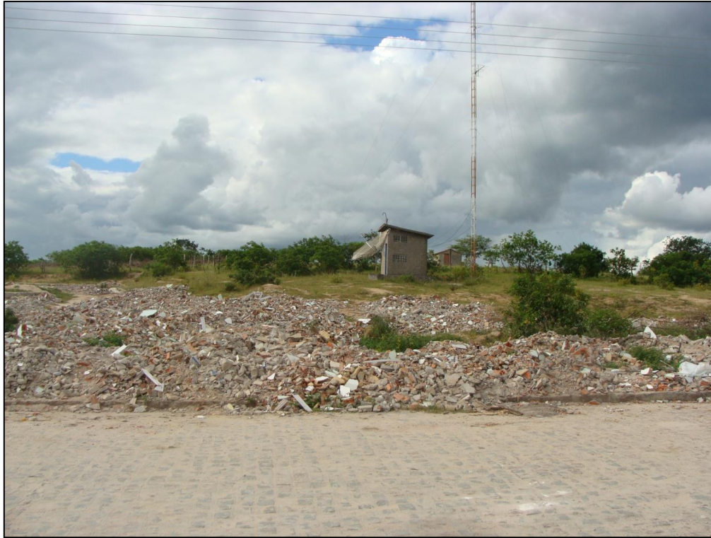
Figura 36: RCD: material inerte – Poço Redondo/SE.
