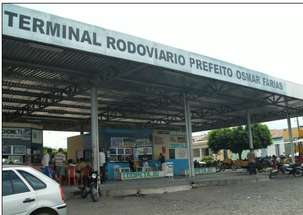
Figura 38: Terminal rodoviário – Monte Alegre de Sergipe/SE.
