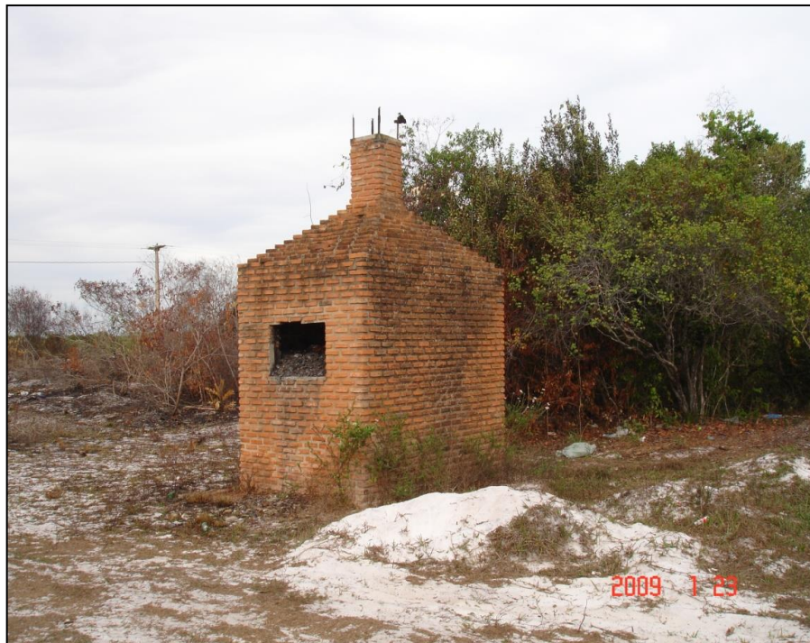
Figura 67: Forno para queima de RSS no lixão hoje desativado. Pirambu –SE. Crédito da foto: Trabalho de Campo. SERGIPE/2009.
