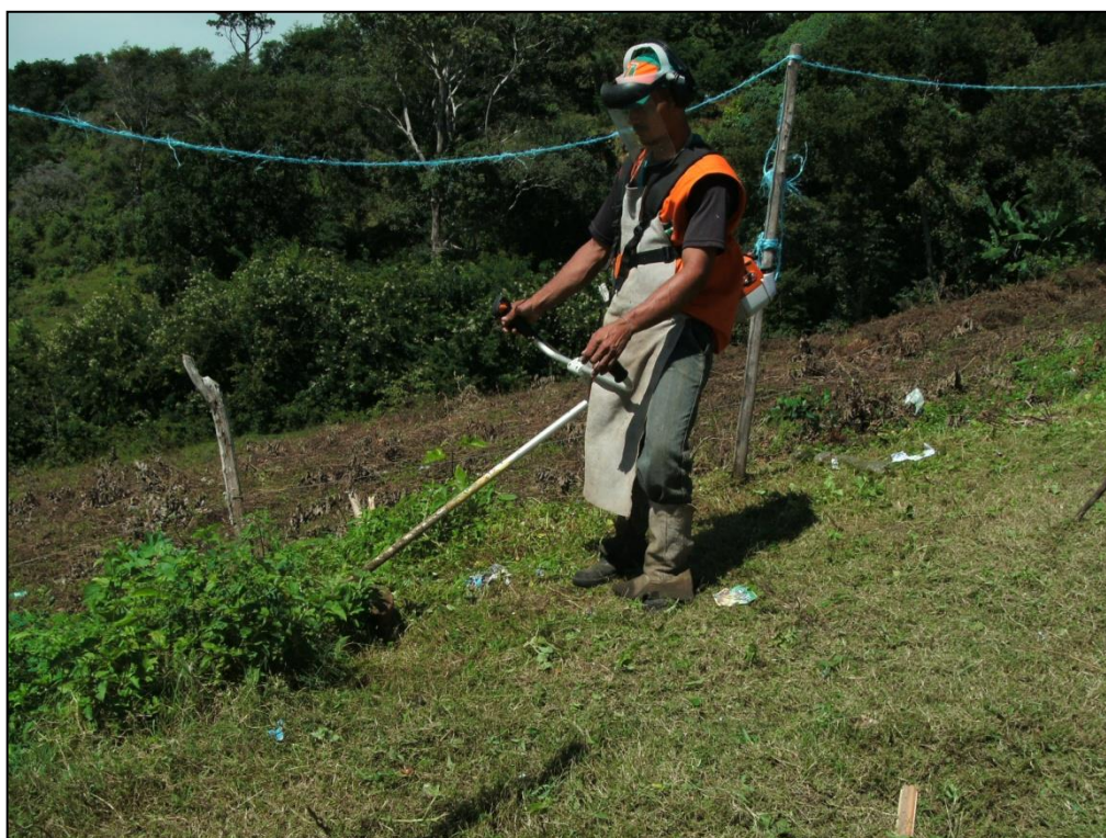
Figura 50: Serviço de capina mecânica – Pacatuba/SE.
