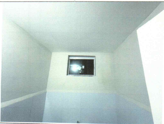
Instalação de Vidro
