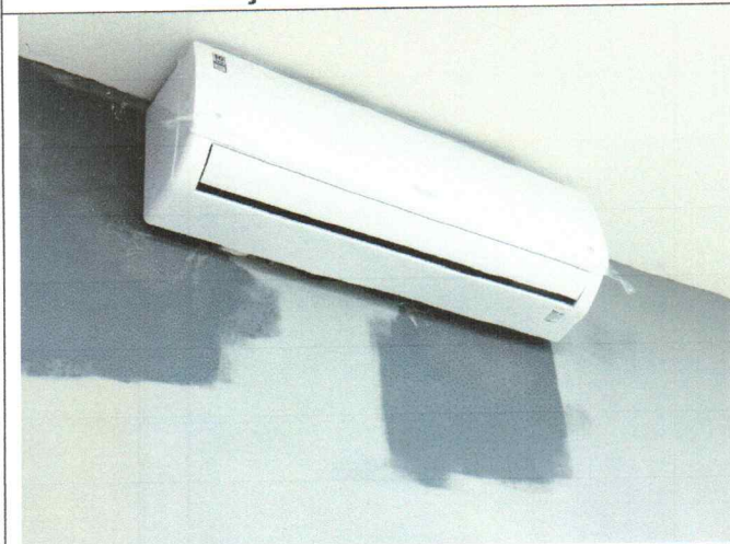
Instalação de Ar condicionado
