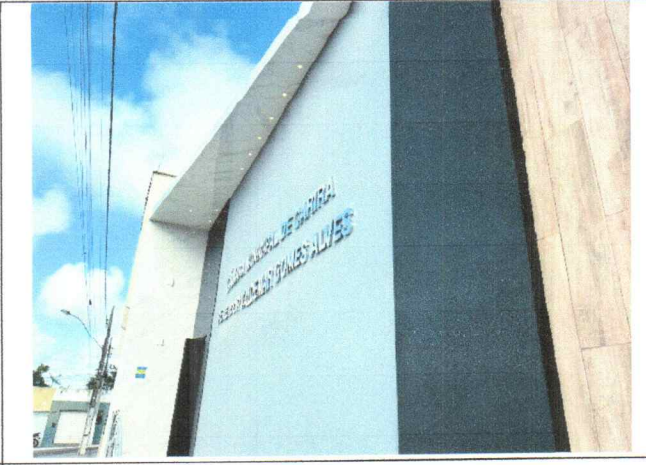
Pintura e Emassamento
