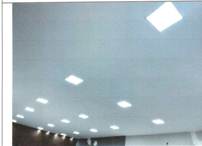
Iluminação e Forro
