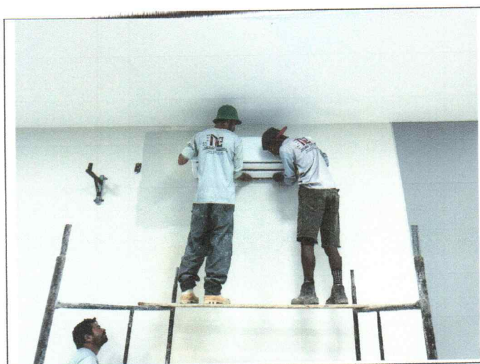
Instalação de Ar condicionado
