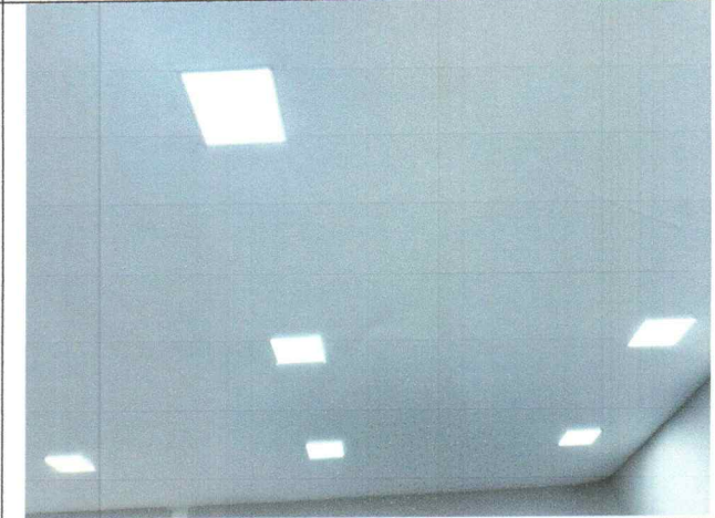
Iluminação e Forro
