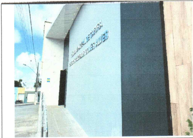
Pintura e Emassamento
