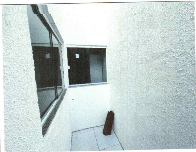
Instalação de Vidro
