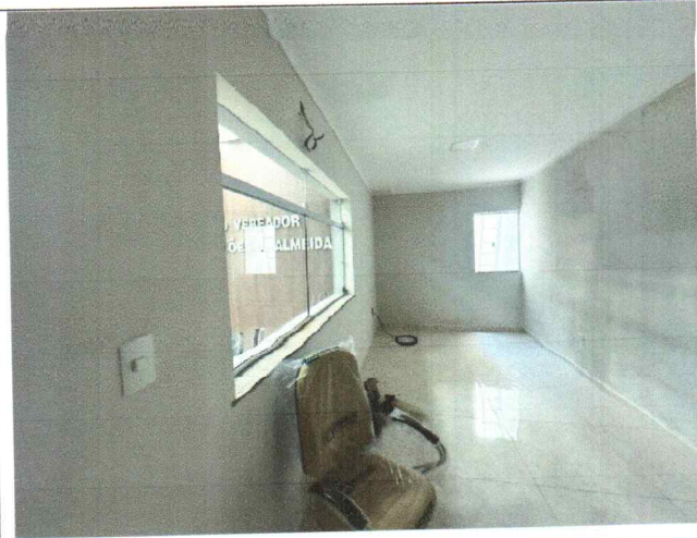
Instalação de Vidro
