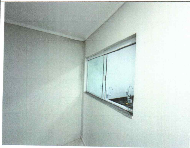
Instalação de Vidro
