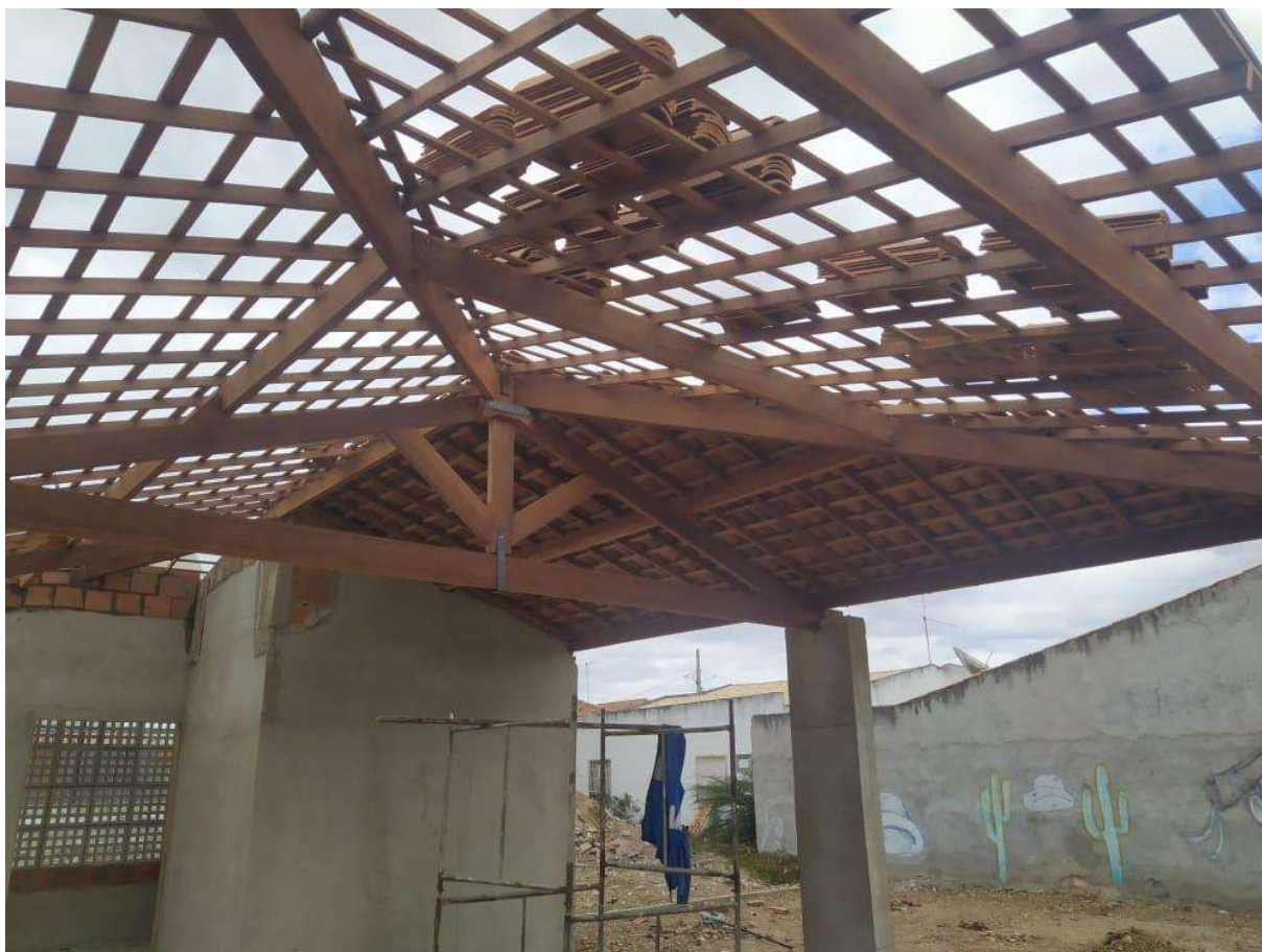
Figura 12: Madeiramento - Cobertura
