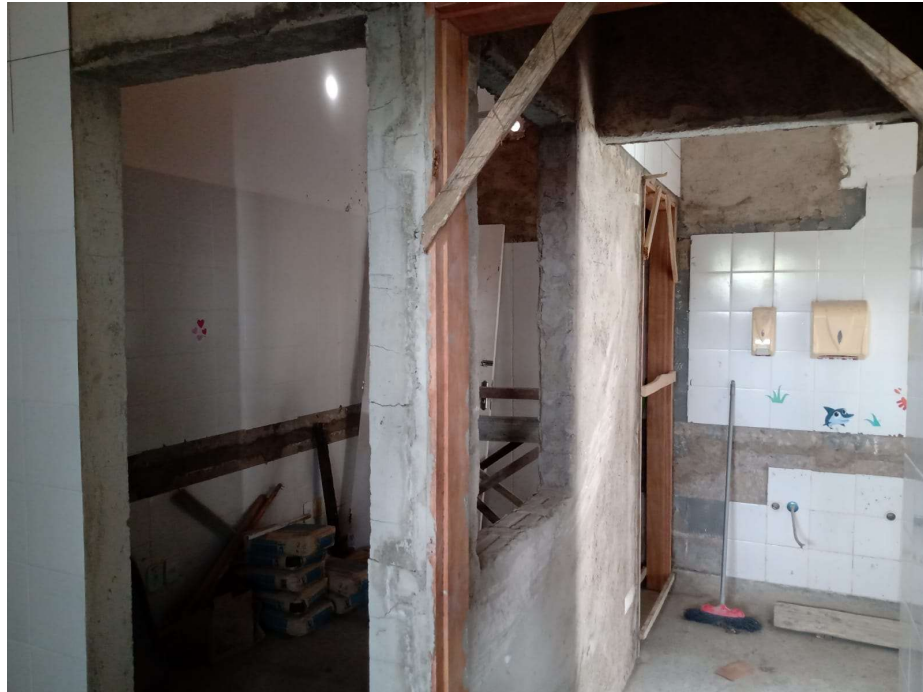
Figura 20: Alvenaria de Vedação
