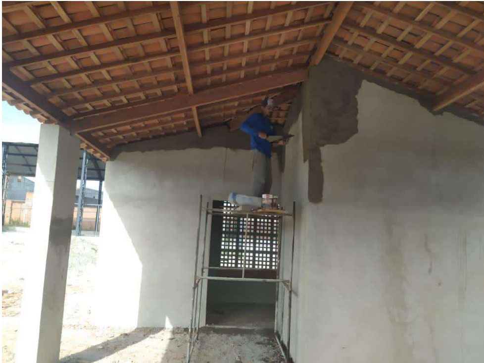
Figura 13: Apoio com cobertura já executada
