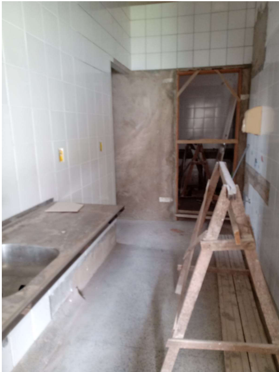
Figura 6: Execução da reforma
