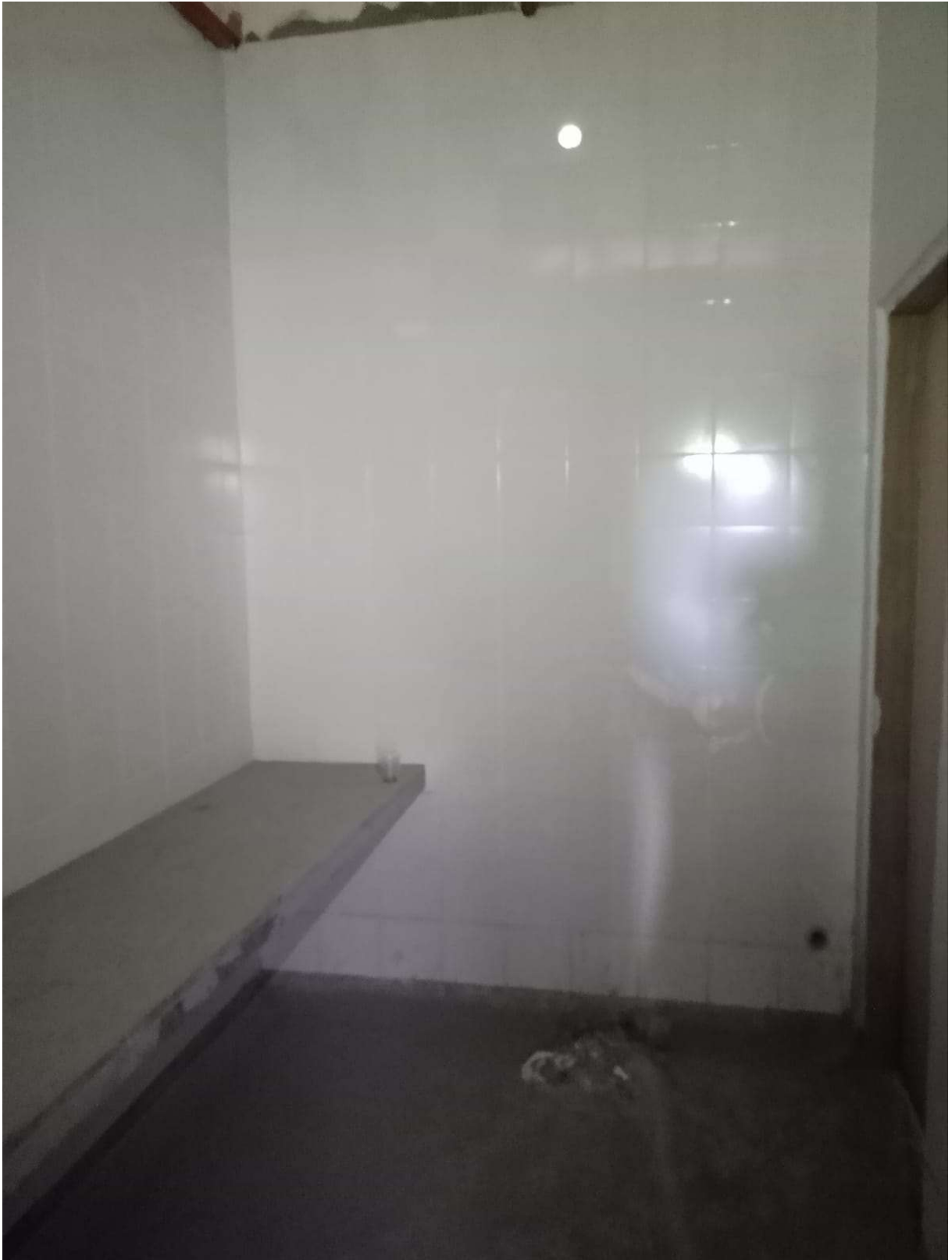
Figura 6: Revestimento Cerâmico executado
