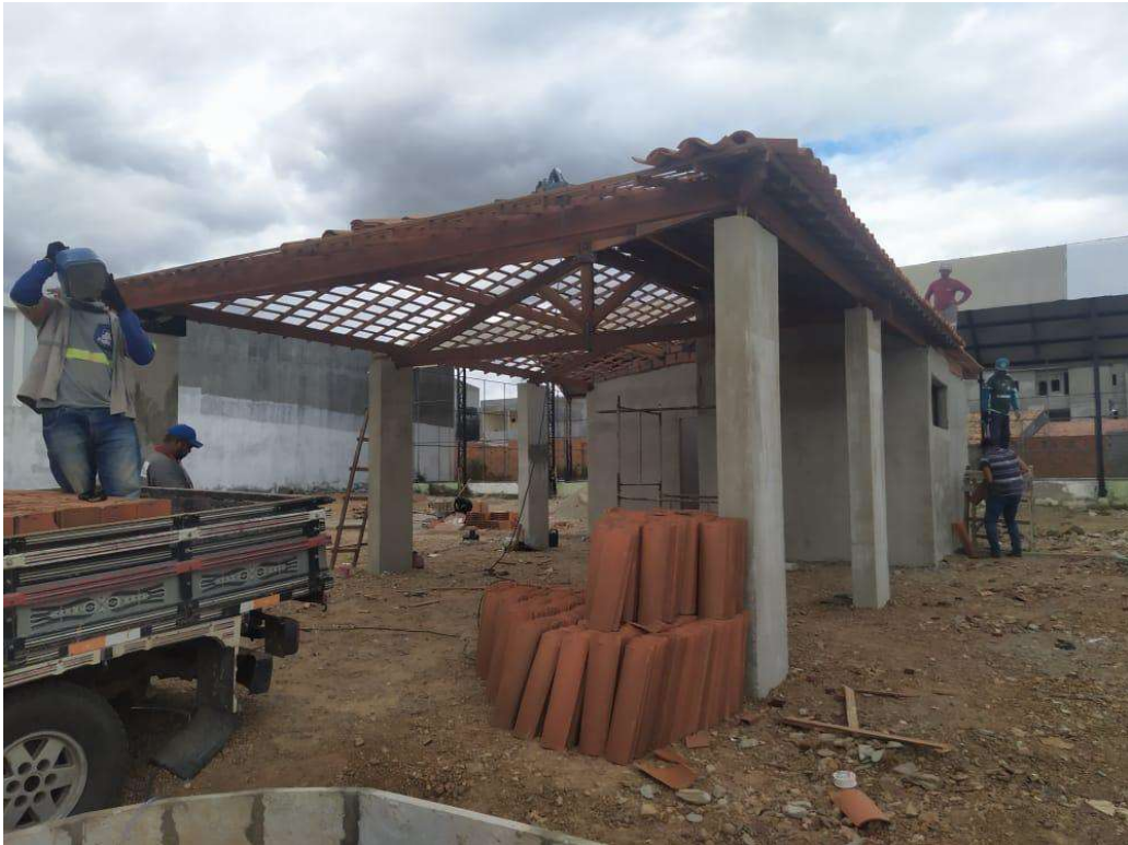
Figura 10: Fachada durante a execução
