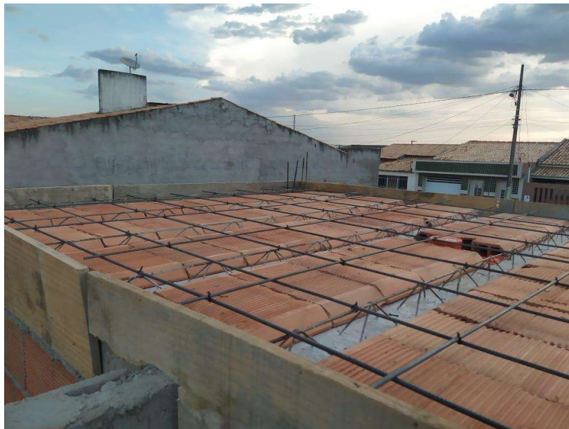
Figura 11: Laje pré moldada – Caixa d'água
