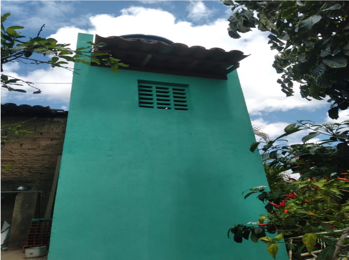
Foto: Melhorias Sanitárias Domiciliares
