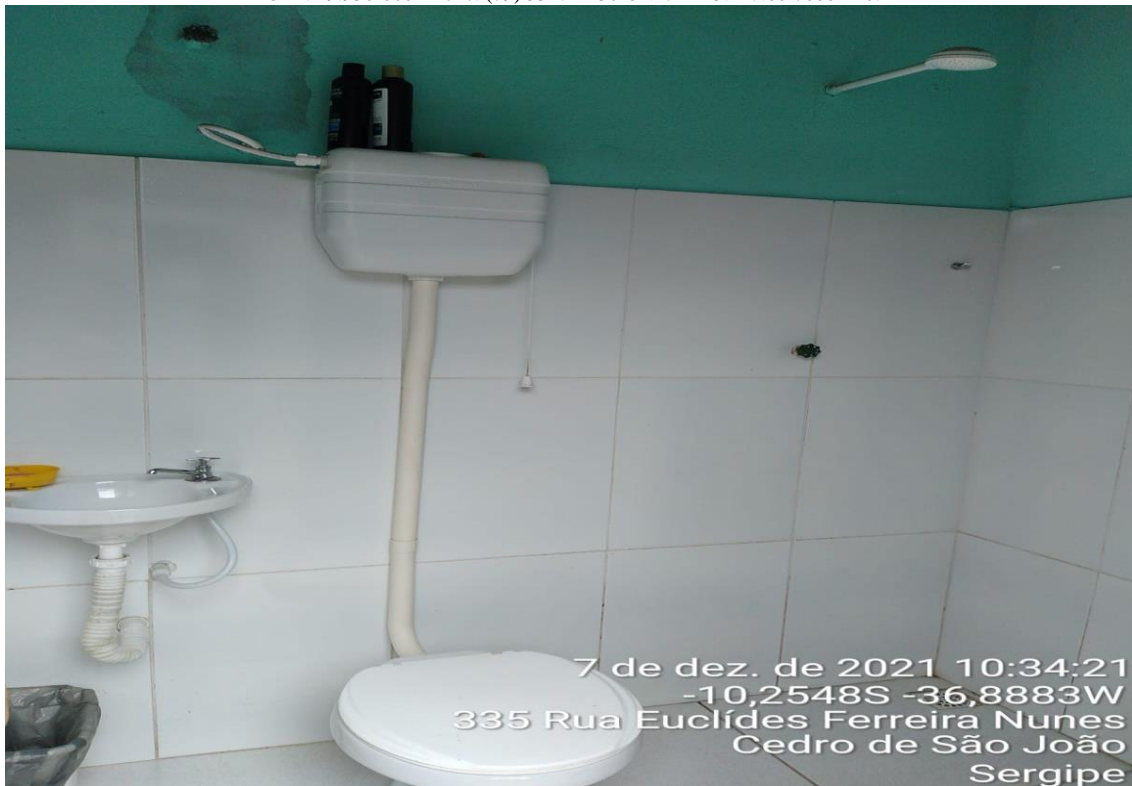
Foto: Melhorias Sanitárias Domiciliares
