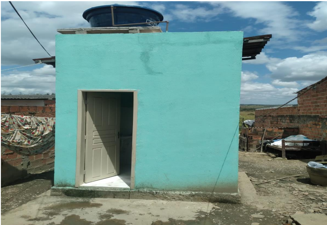
Foto: Melhorias Sanitárias Domiciliares
