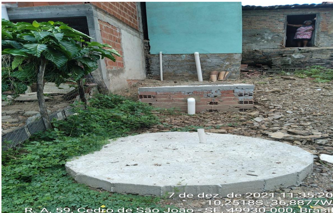
Foto: Melhorias Sanitárias Domiciliares
