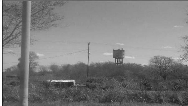
Figura 21: Reservatório no Povoado Descoberto.
