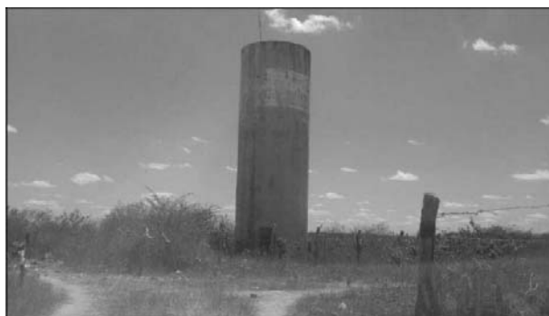
Figura 24: Reservatório do Assentamento Manuel Martins
