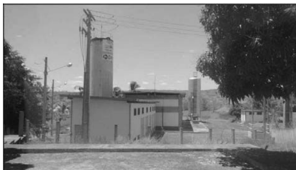
Figura 15: Estação de Tratamento em Porto da Folha
