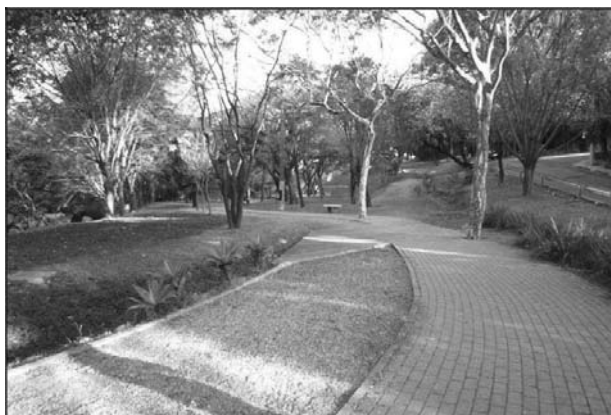
Figura 57: Trincheira de infiltração
