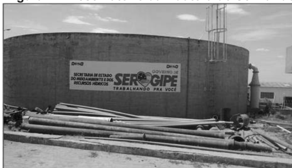
Figura 17: Reservatório da Adutora do Semiárido
