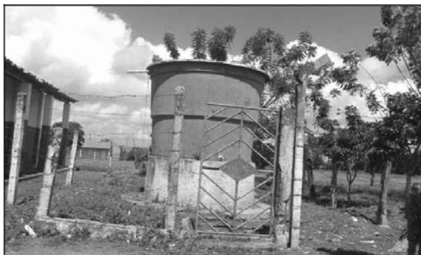
Figura 27: Caixa d'água no povoado Três Tanques.
