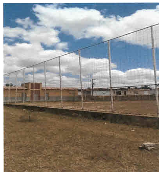
Manutenção de quadra em Nosso Município
